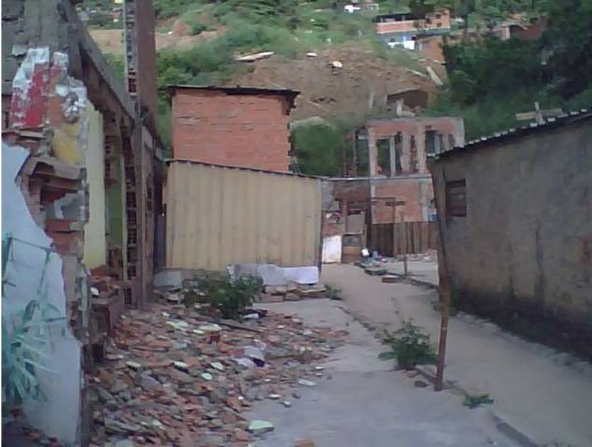
Figura N° 10: Ejemplo de deslizamiento y caída de bloques, con consecuencias en algunas viviendas
