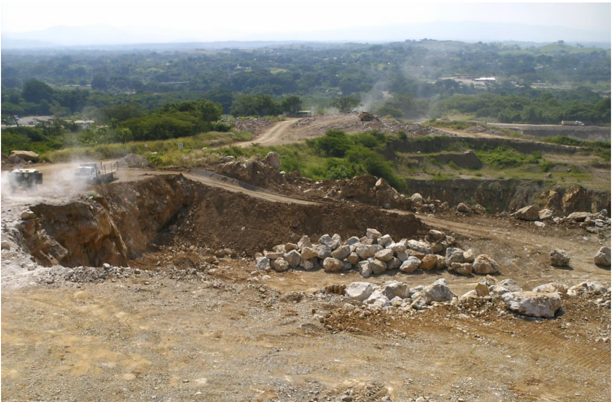
Figura 5: Vista general de la Cantera de San Bernardo
