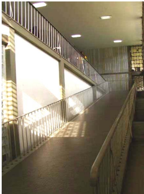
Foto 18. Vistas de las rampas de acceso al primer piso en el Edificio de Humanidades. (Tomadas por los autores)
