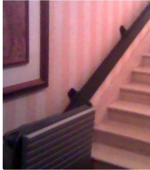
Fotos 25 y 26. Hotel J.W. Marriot, Caracas. Plataforma elevadora, que permite el acceso de discapacitados a las salas de reuniones dentro de dicho hotel. (Tomadas por: Ing. Juan José Tejón).
