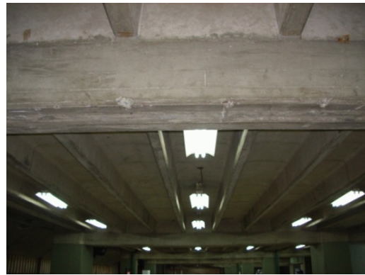
FIGURA II.3.2 Vista inferior de las losas nervadas
