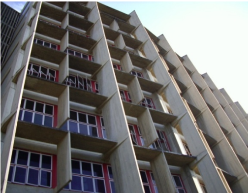
FIGURA II.3.1 Vista externa del edificio de FaCES
