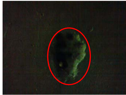
FIGURA IV.3.31 Foto 16 Falta de recubrimiento (3)
