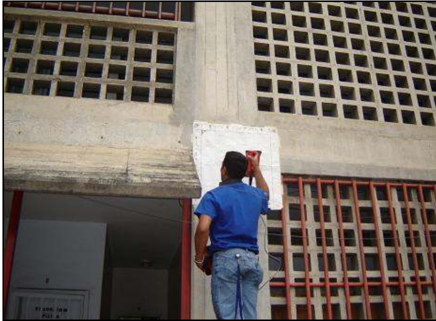
Figura A.35 – Medición con el detector de metales en el nodo B3 desde el patio interno
