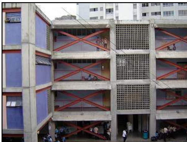
Figura IV.8. Fachada Este de la U. E. N. Julio Bustamante. Se observa el módulo de la escalera y los refuerzos de la edificación.
