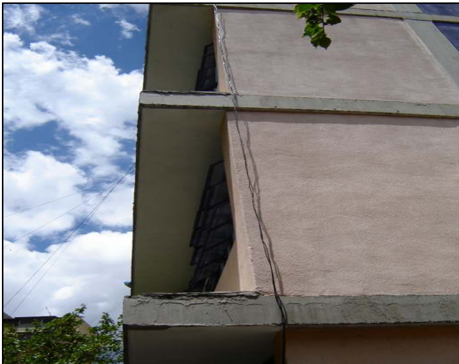
Figura A.08 – Edificio Sur desde la Fachada Sur
