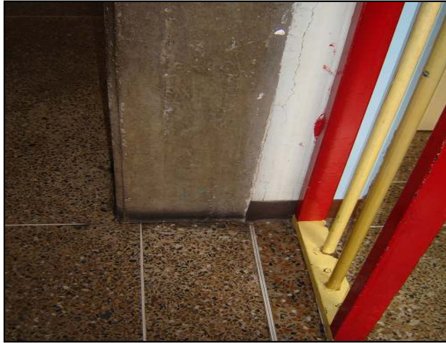
Figura A.19 – Junta en el nivel 1 (Edificio Norte)
