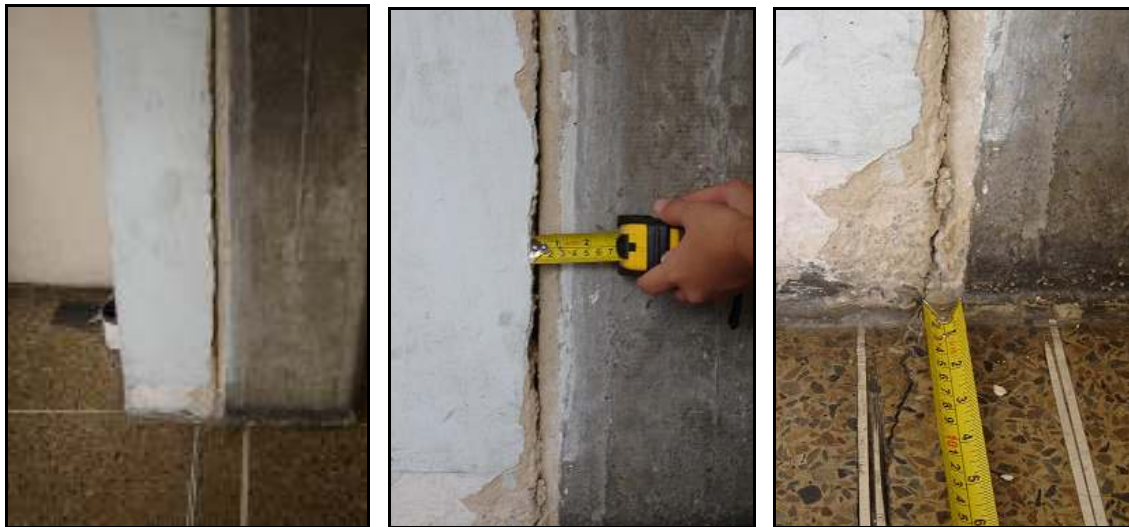
Figura V.25. Junta del edificio Sur en el nivel 3. En las imágenes se observa la gran separación localizada en el último piso del plantel.
