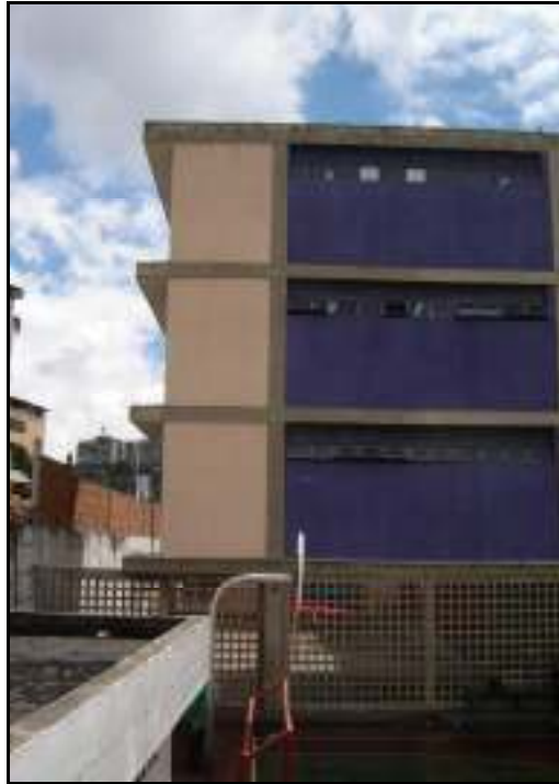
Figura A.29 – Fachada Norte. Se observa el volado de 3.4 m.
