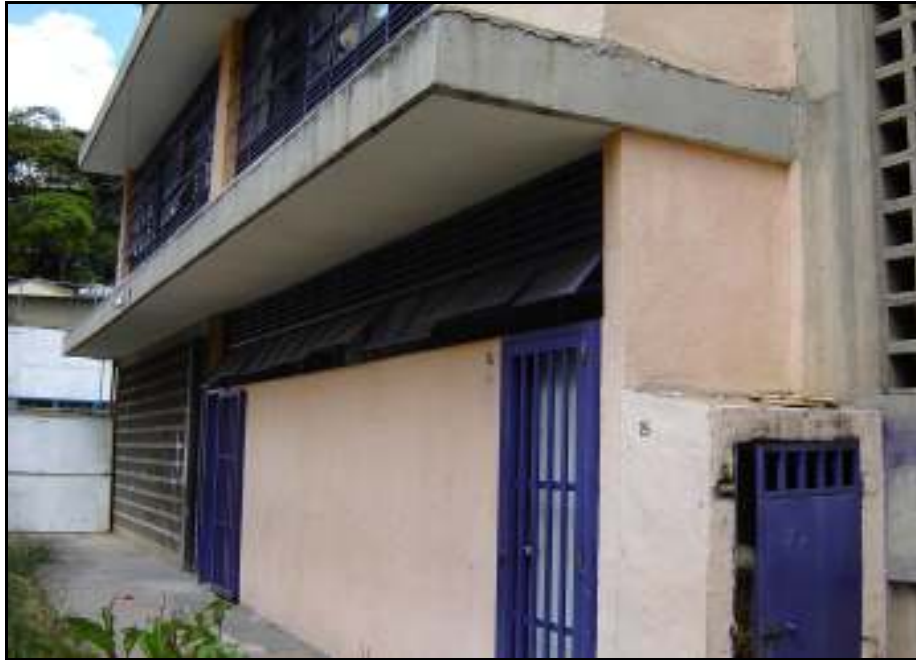
Figura A.11 – Edificio Norte desde la Fachada Oeste en el nivel de planta baja
