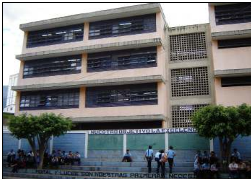
Figura A.10 – Fachada Oeste desde la U. E. N. Julio Bustamante. Se observan las paredes de ventilación que constituyen el módulo independiente de las escaleras
