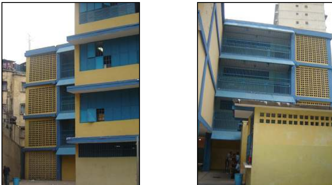
Figura IV.15. A la izquierda se observa uno de los módulos independientes de la escalera, a la derecha se observa el otro; ambos con paredes de ventilación. También se observan las estructuras anexas en la imagen derecha. E. B. N. Elías Rodríguez.
