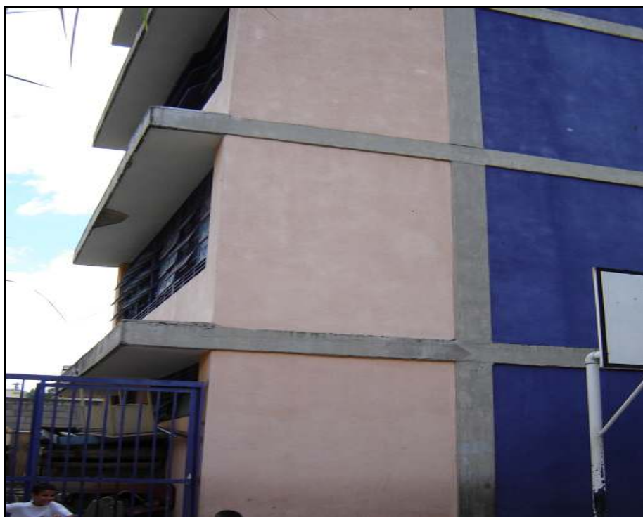
Figura A.06 – Edificio Sur. Se observan los volados desde el patio interno de la escuela
