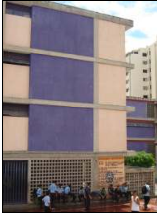
Figura A.27 – Fachada Norte
