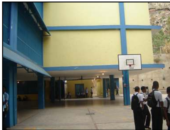
Figura IV.16. Imagen tomada desde el patio central hacia el edificio Este del E. B. N. Elías Rodríguez
