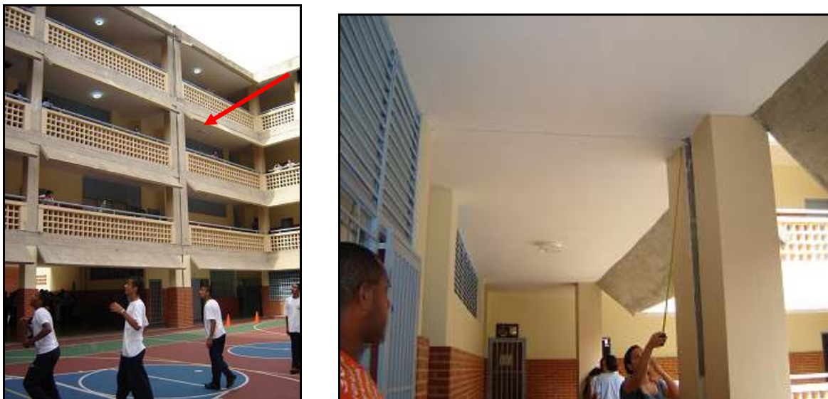
Figura IV.10. Vista general y junta de construcción entre los dos edificios con una separación de 7 cm. E. B. N. Fernando Peñalver
