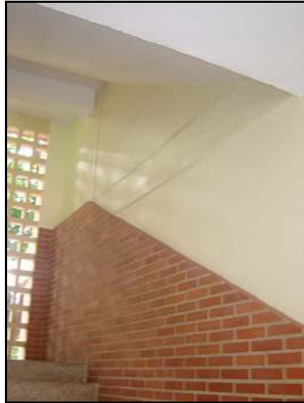
Figura IV.12. Escaleras de acceso a los niveles superiores. En la imagen se puede apreciar la presencia de vigas altas en ambas direcciones. E. B. N. Fernando Peñalver.
