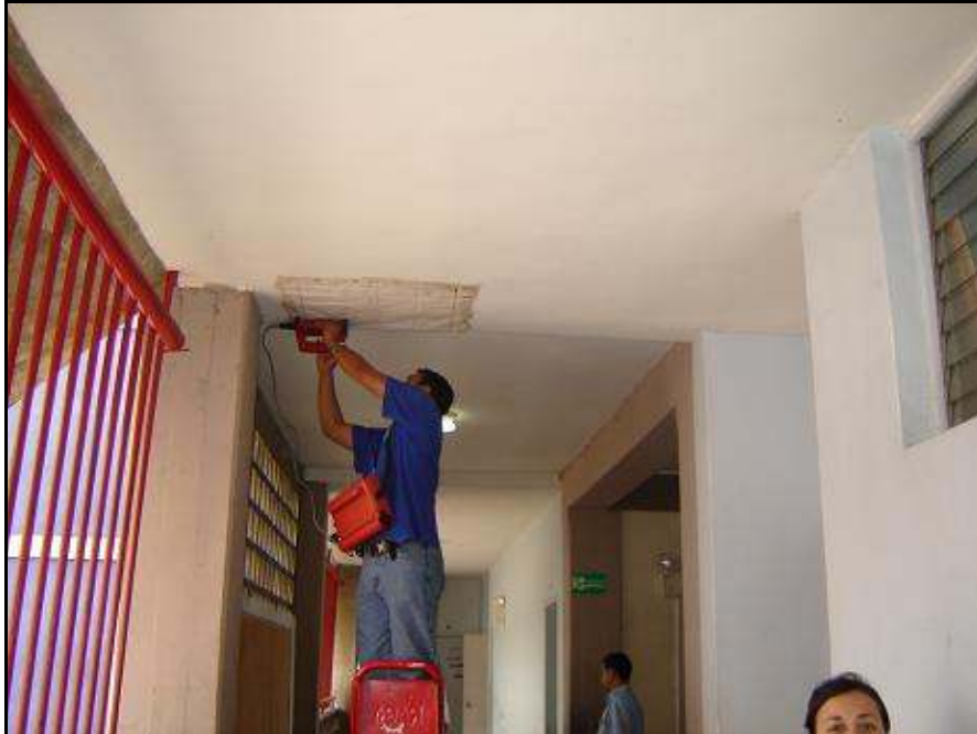
Figura A.36 – Medición con el detector de metales en el módulo de la escalera
