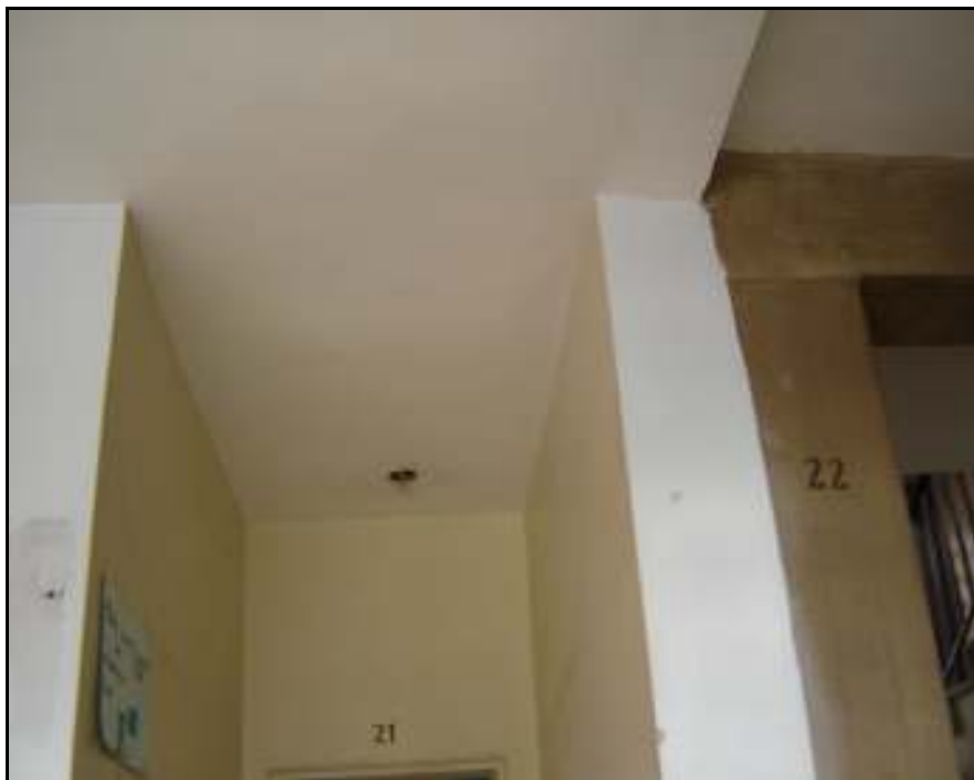
Figura A.20 – Junta en el nivel 1 (Edificio Sur). A la derecha se observa la columna B'3' y una viga del módulo de la escalera.
