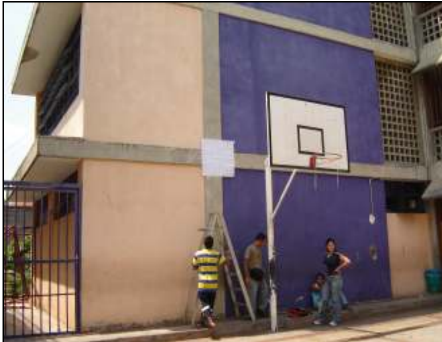
Figura A.34 – Edificio Sur desde el patio interno. Se aprecia la plantilla utilizada para la medición con el detector de metales, ubicada en el nodo A2.
