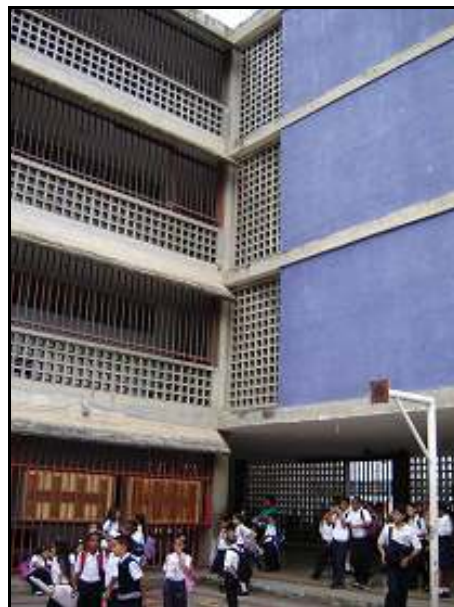
Figura IV.4. Fachada Este de la U. E. N. Padre Sojo. Fotografía tomada desde el patio interno de la escuela. Se observa la presencia de paredes de ventilación, parasoles y planta baja libre del edificio Norte
