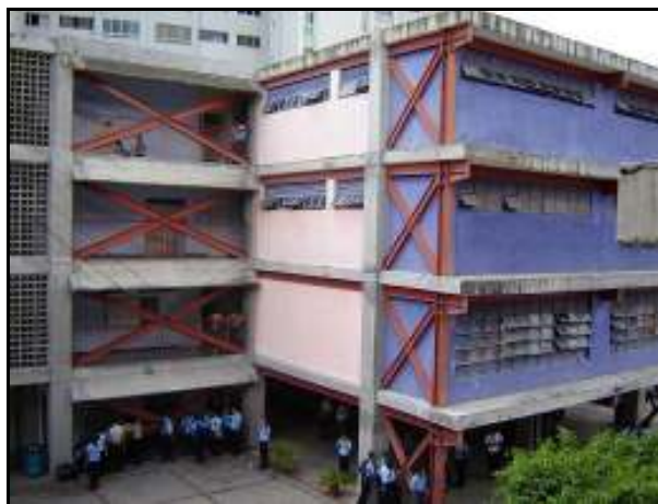
Figura IV.7. Fachada Este de la U. E. N. Julio Bustamante. Se observa el pórtico adicional que dicha edificación presenta y el refuerzo colocado en el mismo.
