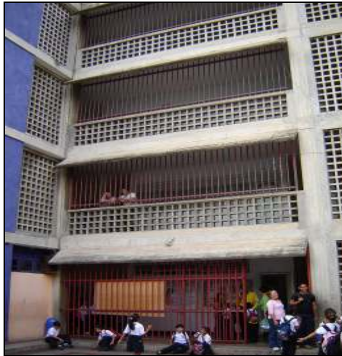
Figura A.09 – Fachada Este. A la izquierda se encuentra el Edificio Sur, donde se aprecian las paredes de ventilación y los parasoles del patio interno del plantel
