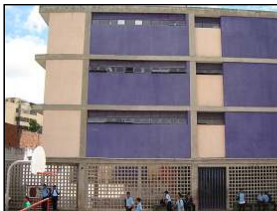
Figura V.2. Imagen de la Fachada Norte, donde se aprecian los 4 niveles estructurales con dimensiones de 6,90 m. y el volado de 3,40 m. U. E. N. Padre Sojo.
