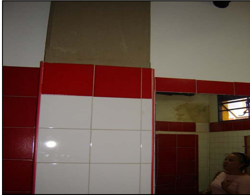
Figura A.21 – Columna C2 ubicada en el baño de mujeres de Planta Baja
