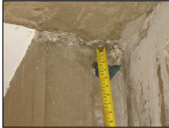
Figura V.24. Junta del Edificio Norte en la parte inferior de la losa del nivel 2
