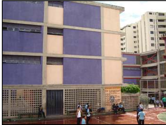
Figura IV.3. Fachada Norte de la U. E. N. Padre Sojo. Se aprecia la dimensión 6,90 m y el volado de 3,40 m. Al fondo se encuentra la U. E. N. Julio Bustamante.
