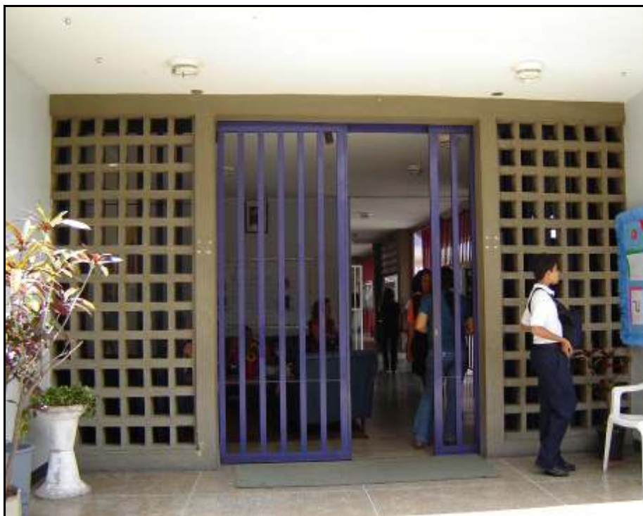
Figura A.04 – Entrada de la escuela. Se observa presencia de paredes de ventilación
