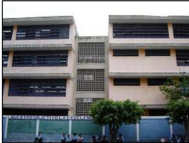
Figura IV.5. Fachada Oeste de la U. E. N. Padre Sojo. Se observan las paredes de ventilación en el módulo de la escalera.
