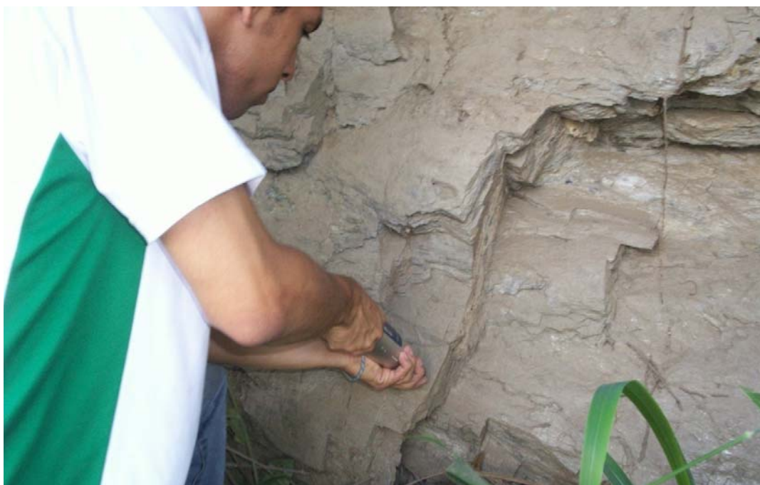
Figura #51. Evidencia del diaclasado en la sección CDN-002, perteneciente al sector #2 (S2) del túnel Mampote.
