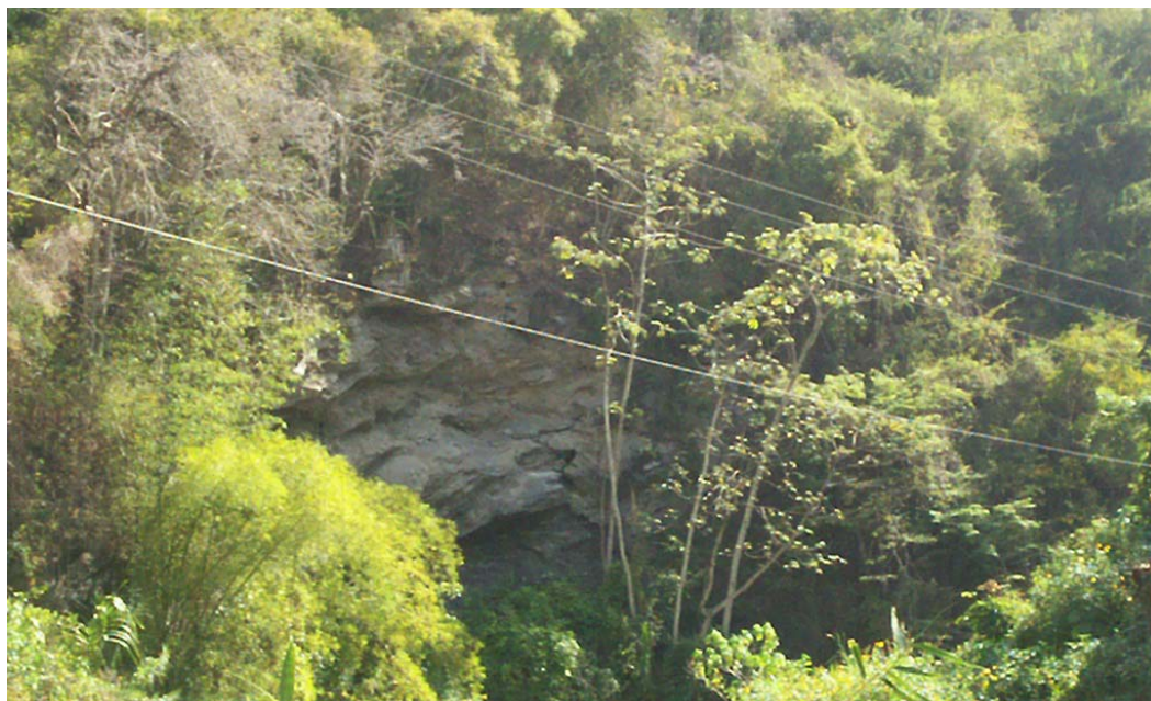
Figura #32. Evidencia de la foliación en la quebrada Valencia, perteneciente al túnel La Encantada.
