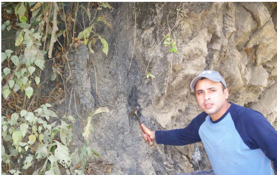
Figura #30 Evidencia de falla en el margen Oeste de la quebrada La Encantada.
