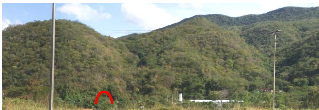
Figura #9. Portal de entrada del túnel de Mampote, visto desde la autopista Caracas Guarenas. Rumbo E-O.
