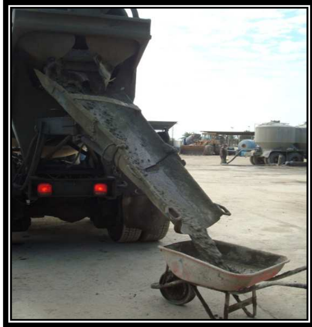
Imagen III.7.- Vaciado
