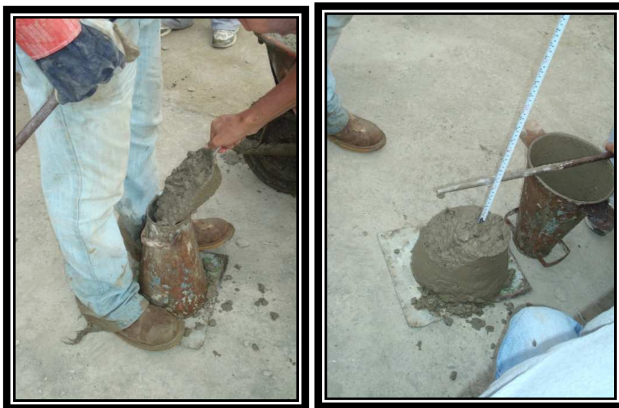
Imagen III.10 y III.11.- Medición del asentamiento
