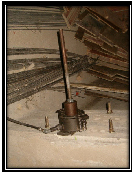
Imagen III.24.- Ensayo de extracción al anclaje de barra roscada con resina epoxica
