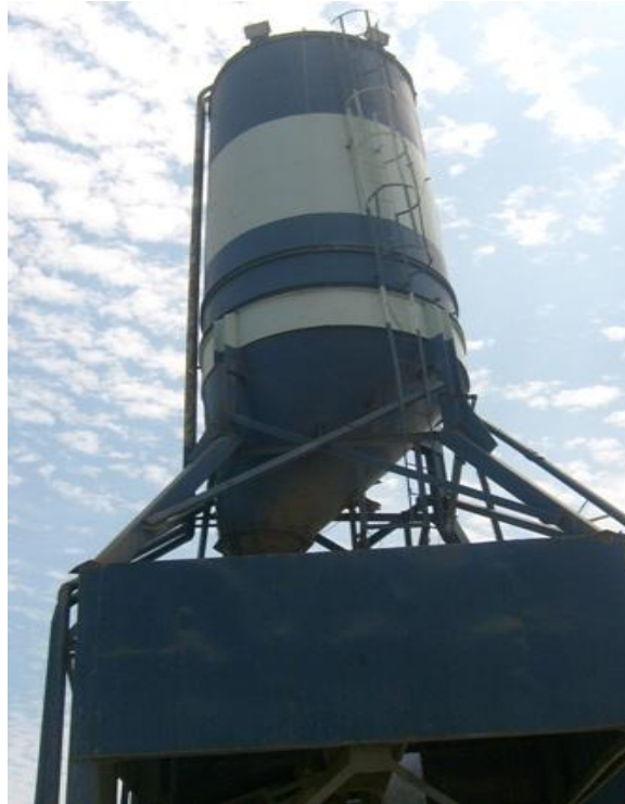
Figura III.3: silo almacenador de cemento ubicado en Planta Premezcladora Rapid Concreto.
