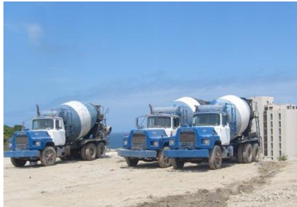
Figura III.21: Camiones mezcladores de tambores con capacidad de 7m^3 .
