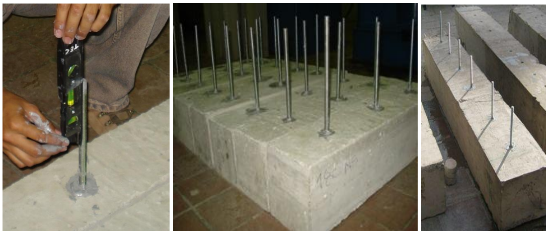
Figura III.62: Nivelación vertical del anclaje y disposición final de los anclajes
