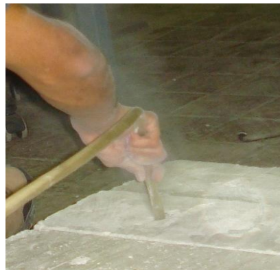
Figura III.59: Extracción de polvo en los orificios con aire a presión.
