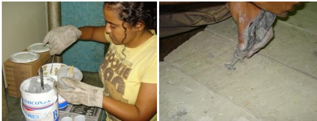
Figura III.61: Preparación y colocación de resina epóxica.
