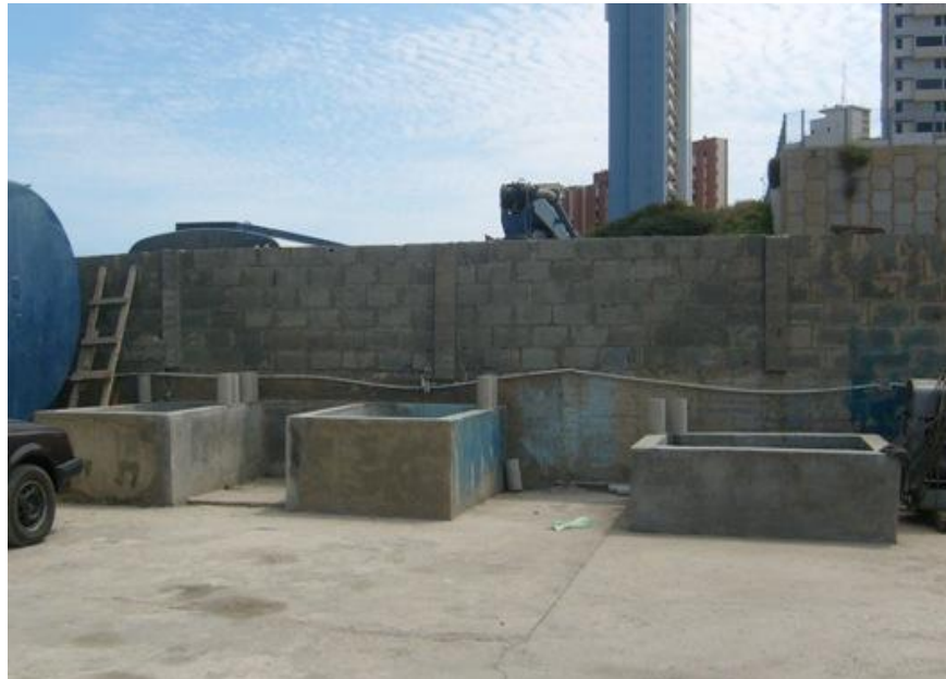
Figura III.5: Piscinas dispuestas para el curado de cilindros y viguetas, ubicado en Planta Premezcladora Rapid Concrete.
