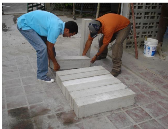
Figura III.56: ordenamiento de viguetas
