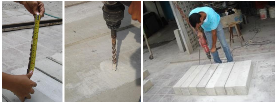
Figura III.58: Perforación de la viguetas con el taladro roto-percutor Hilti.
