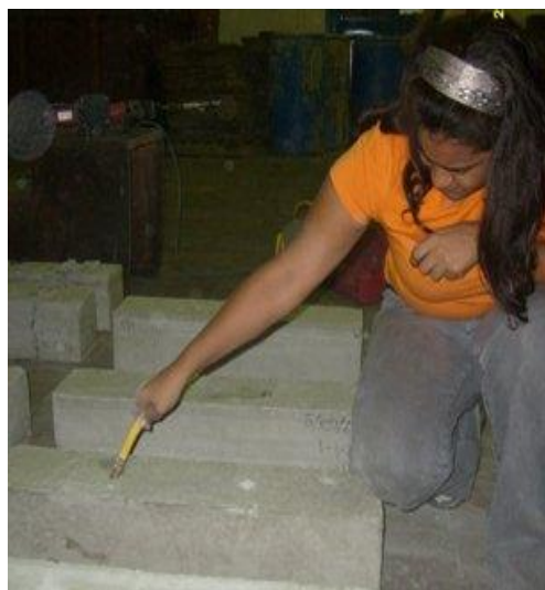
Figura III.50: Extracción de polvo de los orificios.
