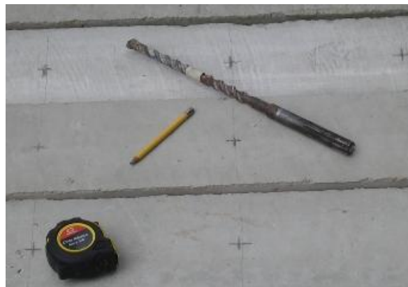
Figura III.48: Mecha de 5/8" de diámetro marcada con la profundidad de perforación deseada.
