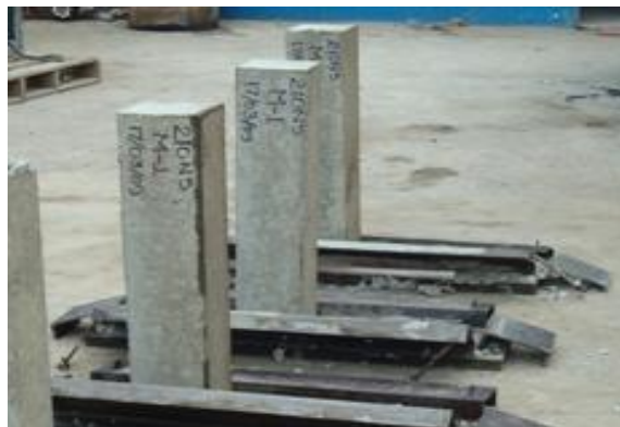
Figura III.30: Desencofrado de viguetas.
