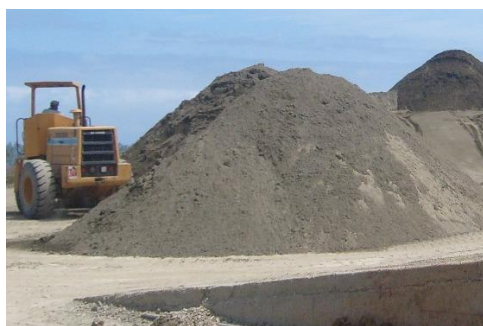
Figura II.1: Agregado Fino, arena.
