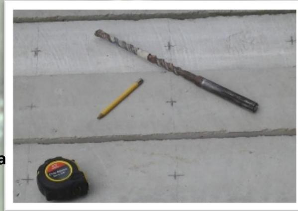
Se marcó la broca de 5/8" con una altura de 10 cm para identificar la profundidad de la perforación
