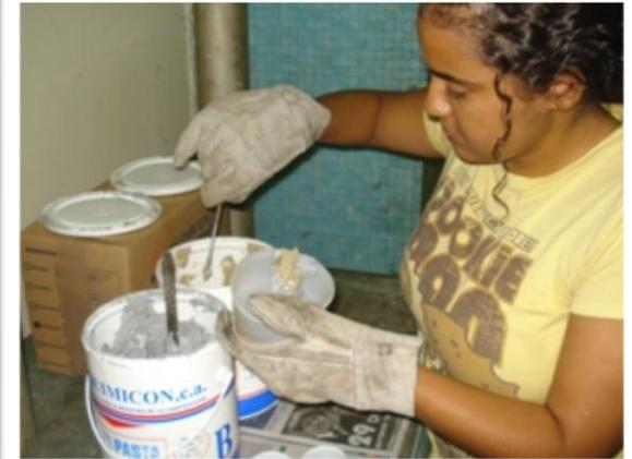
**Mezcla de la resina epóxica en pasta. (Componente A con componente B).**
