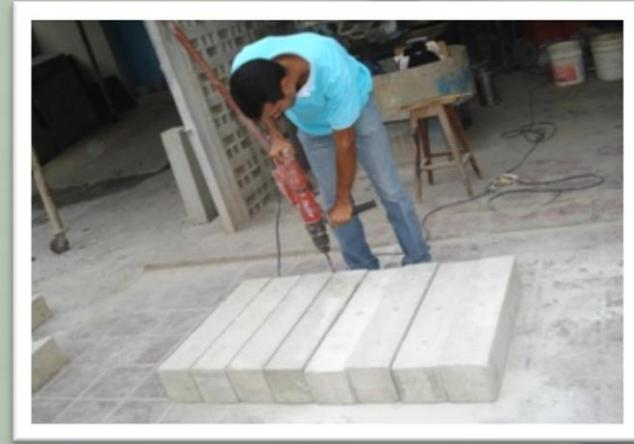
Perforación de viguetas con mecha de 5/8" de diámetro con la profundidad de perforación de 10 cm. Espacio entre perforaciones de 25 cm
