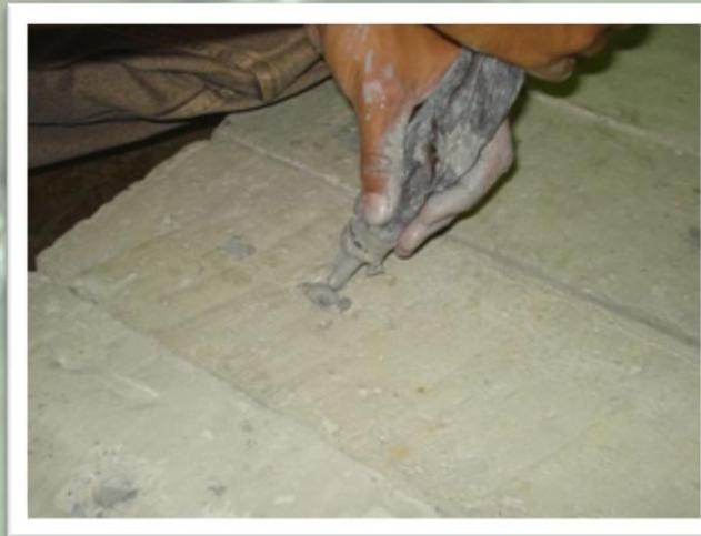
**Colocación de epóxico en orificios de las viguetas**
