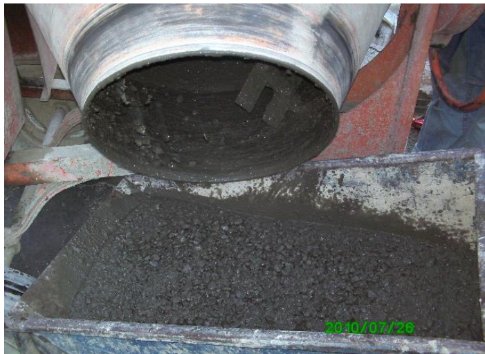
Anexo 11. Disposición de la mezcla en la carrucha para posterior transporte al lugar de vaciado
