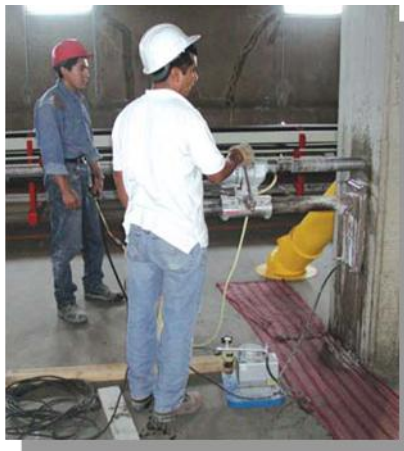
Imagen 1. Equipo de extracción de núcleos.
