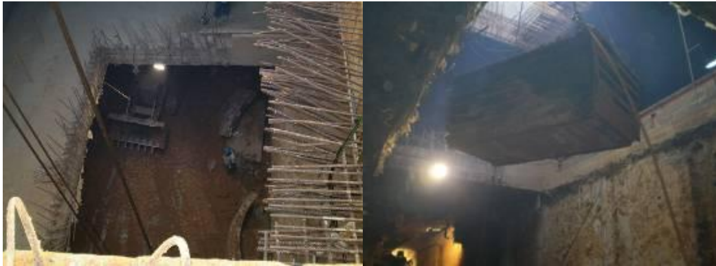
Figura 37. Izquierda: receso de la losa de mezzanina y receso externo. Fuente: Elaboración Propia. (2010)
