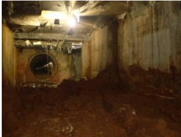
Figura 38. Sección de la trinchera tipo túnel en construcción. Fuente: Elaboración Propia. (2010)
