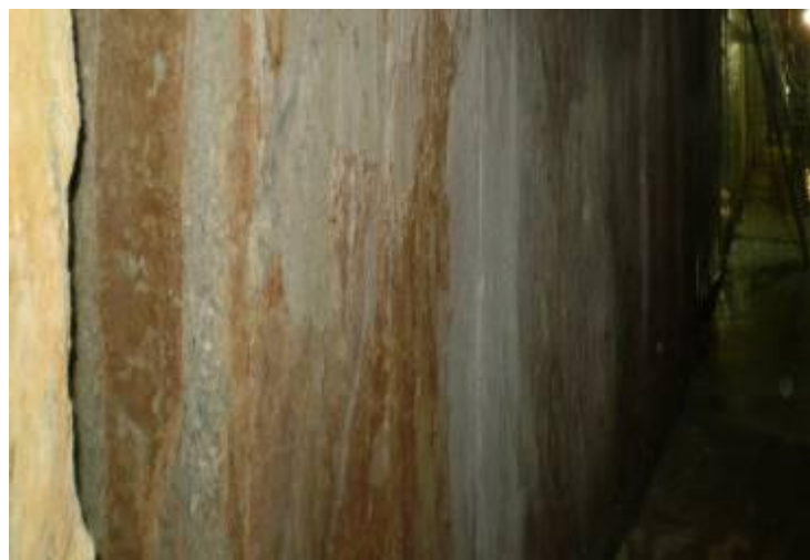
Figura 39. Vista del muro colado central de la estación. Fuente: Elaboración Propia. (2010)
