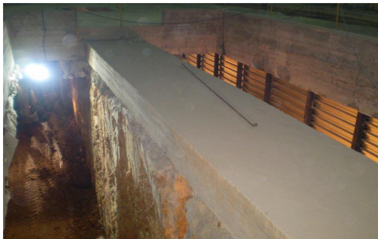
Figura 29. Muro Colado Central de Concreto Armado - Estación Jardines.
