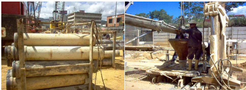
Figura 35. Proceso de Ejecución del Muro Colado de la Línea 3. Vista A: Tuberías para el vaciado. Vista B: Vaciado del muro colado. Fuente. Tralci, 2006.
