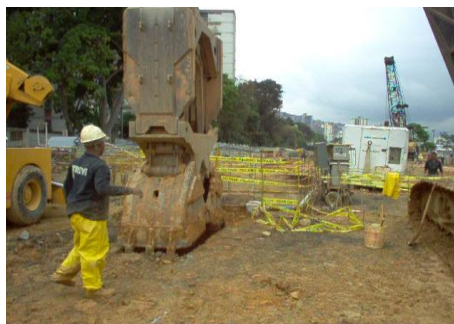
Figura 33. Excavación de muros colados. Fuente. Tralci, 2006.
