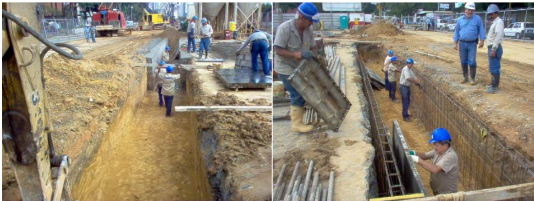
Figura 31. Proceso de Ejecución del Muro Colado de la Línea 3. Vista A: Excavación de Muro Guía. Vista B: Armado de Muros Guías. Fuente: Elaboración Propia.
