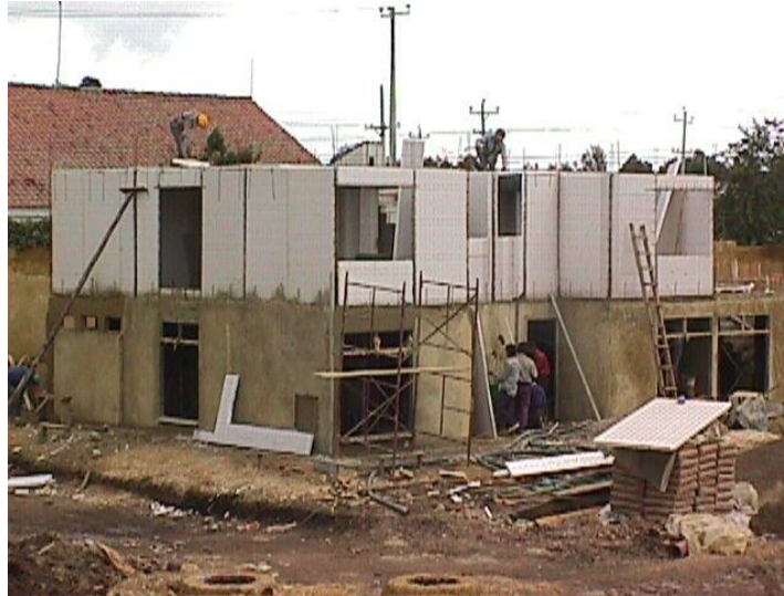
Ilustración 11: Vivienda Construida a través de Paneles EVG 3D. Fuente: Sistema de Construcción VIS (2010)
