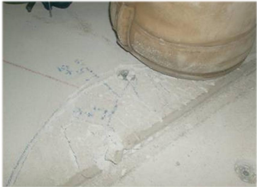
Foto No. 4: Ensayo de Impacto, falla por aplastamiento del recubrimiento (II)
