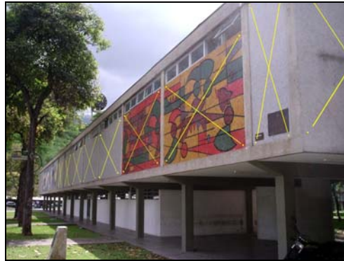
Figura 32 Modelado con diagonales equivalentes
