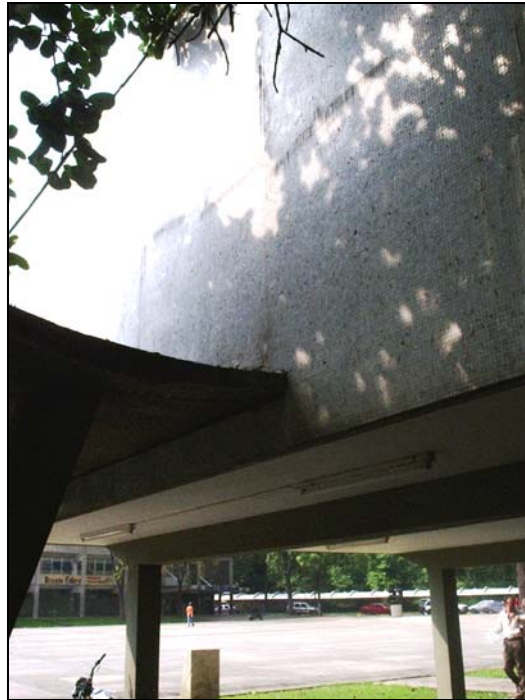
Figura A.5.2.1 Otro detalle de la unión del techo con forma de concha y el edificio
