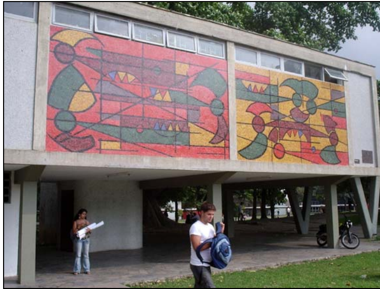
Figura A.5.4 Mural de Oswaldo Vias - Estado actual Fuente: Propia
