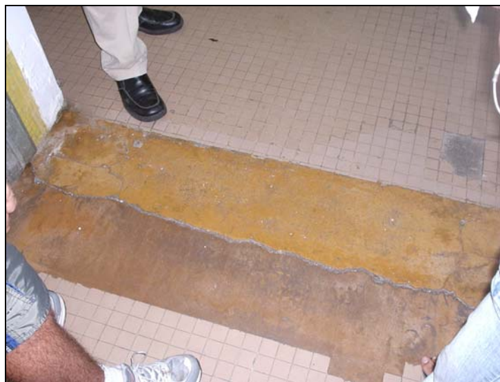
Figura A.5.3 Junta entre el edificio y escalera de acceso
