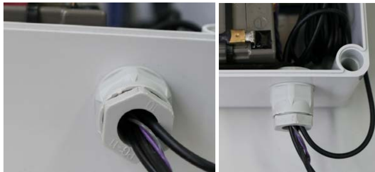
FIGURA 6.4 Prensaestopa colocada en la caja de resguardo
