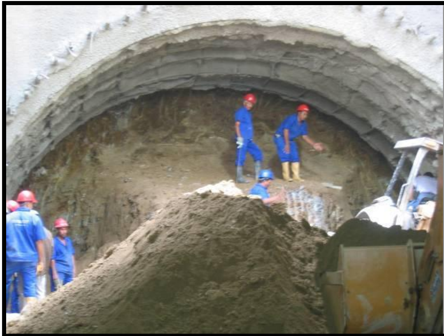
Anexo 2. Excavación del túnel minero.
