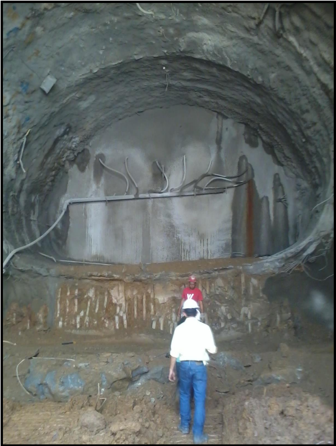
Anexo 21. Inspección del foso.
