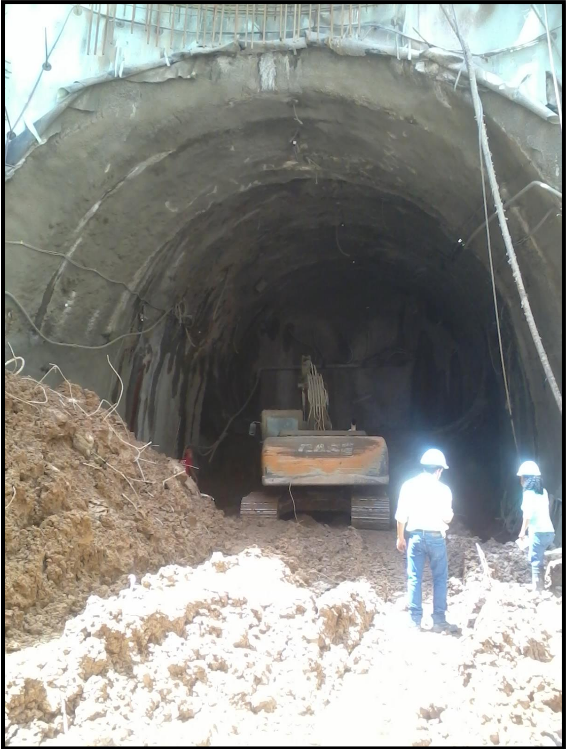
Anexo 20. Foso de excavación, Solo aire, Túnel de ventilación.
