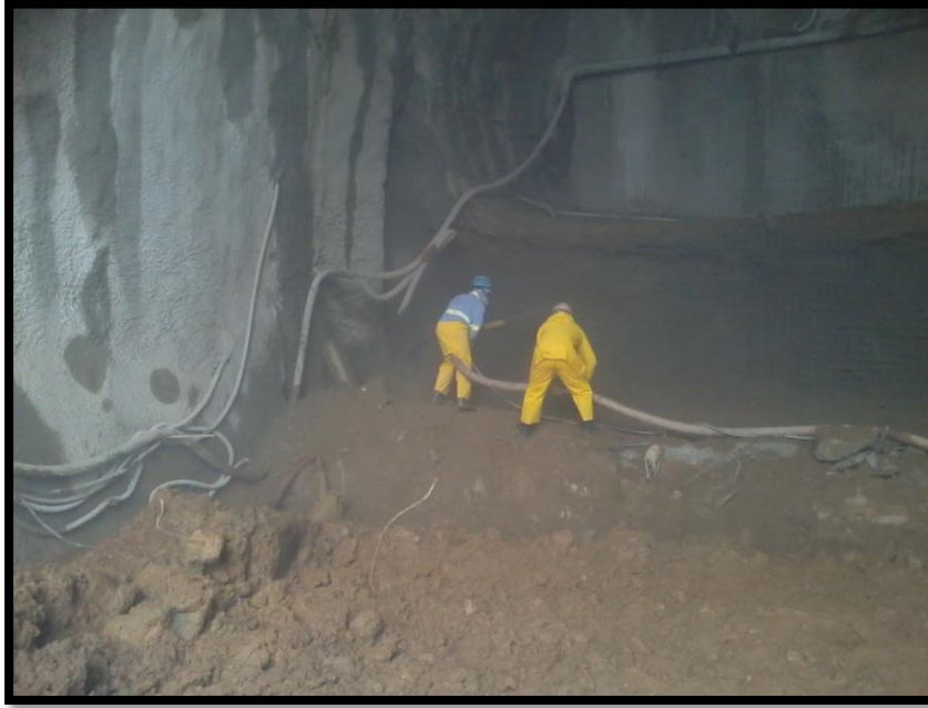
Anexo 1. Concreto Proyectado
