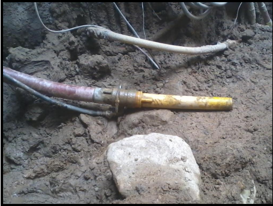
Anexo 22. Manguera para el concreto proyectado y para el aditivo.
