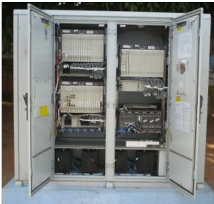
Figura 18 Gabinete del equipo ONU-F01D1000
