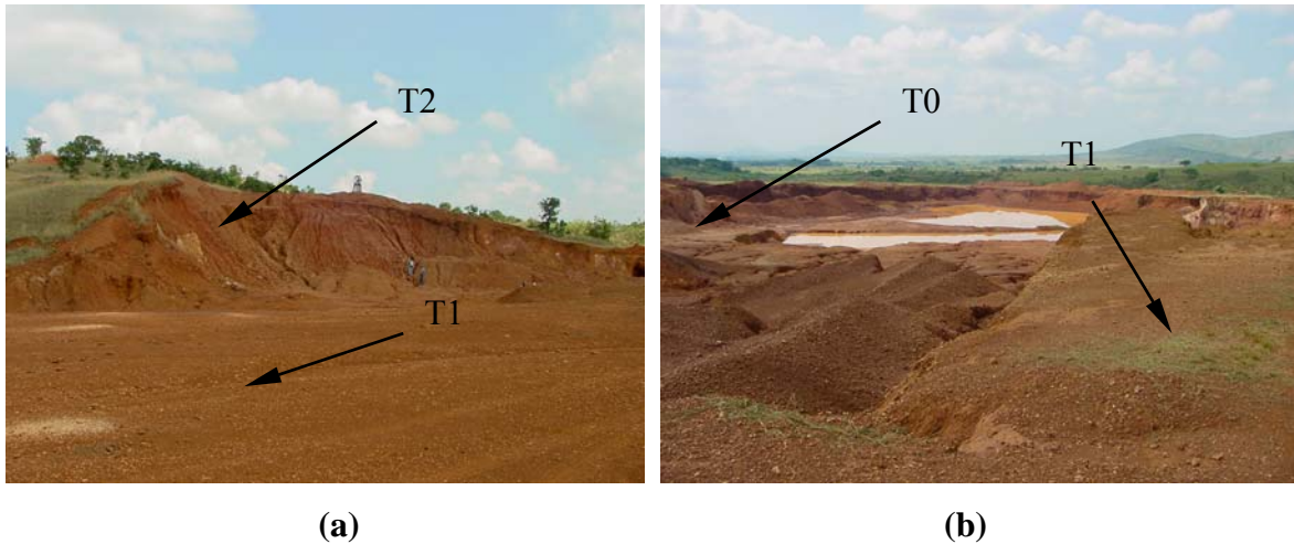
Figura 3.1. Vista de los tres frentes de la mina estudiada (Damica): (a) Cota superior (T2) y Cota intermedia (T1). (b) Cota intermedia (T1) y Cota inferior (T0).
