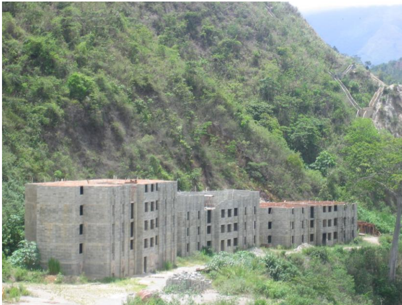
Anexo # 8: Parte de las edificaciones inconclusas del proyecto habitacional Simón Rodríguez
