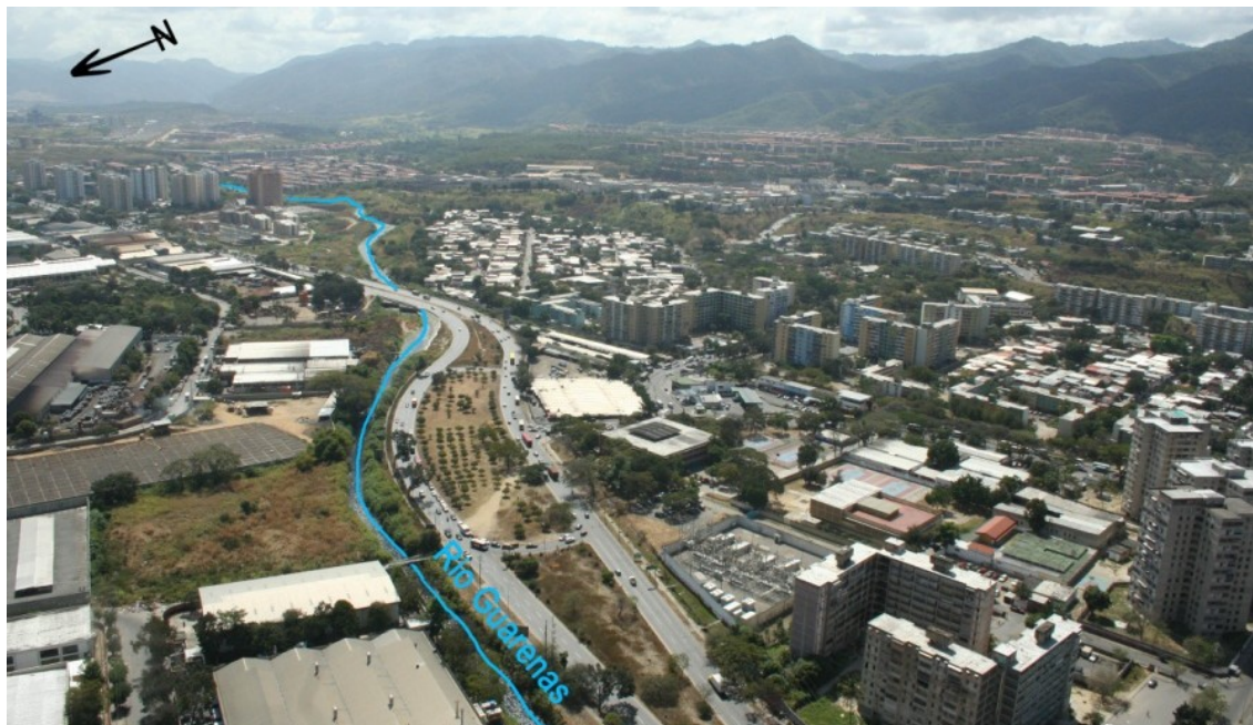
Figura 2.12. El río Guarenas en el valle Guarenas-Guatire. En la imagen se traza el recorrido del río Guarenas a través de la ciudad de Guarenas, donde parte de su curso esta canalizado a favor de la expansión urbana. Rumbo de la vista: S65°E.
