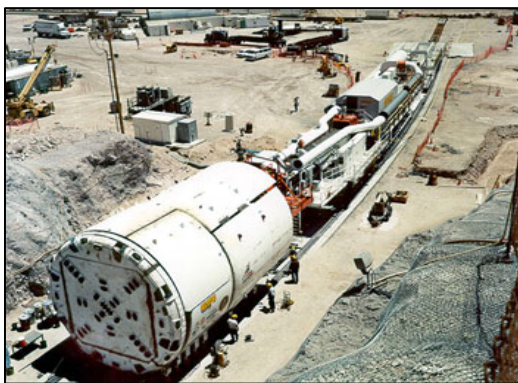
Foto 1.1.a. Máquina TBM tipo escudo utilizada para excavar túneles.
