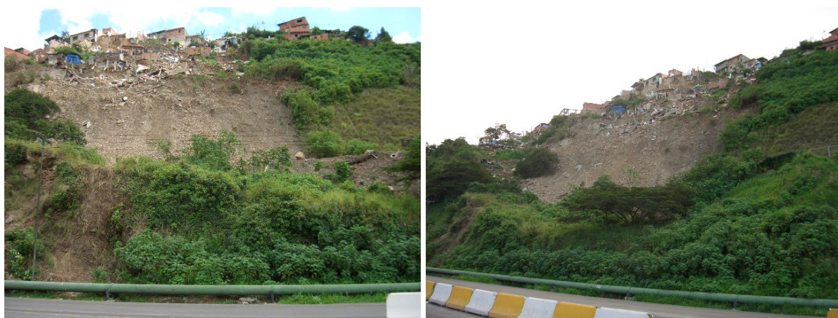
Figura 6.22 Deslizamiento reciente ocurrido en la progresiva 1+400
