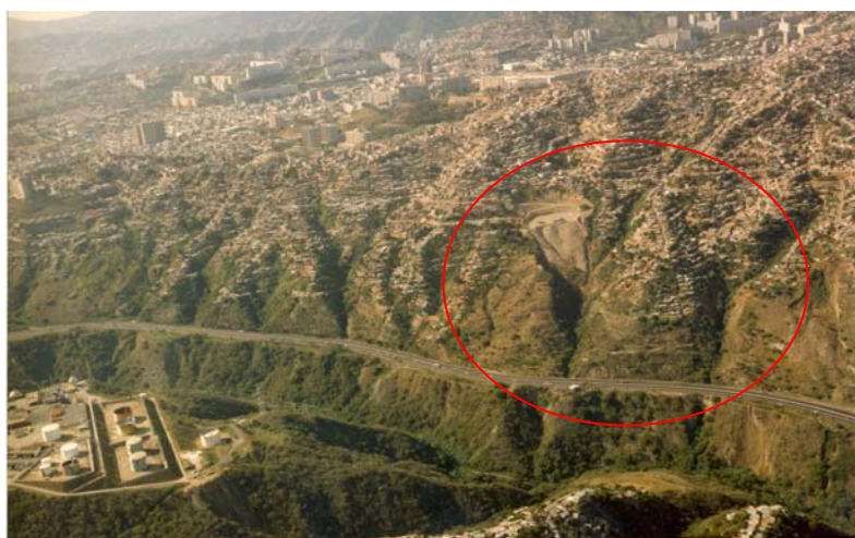
Figura 6.25.- Foto tomada desde un helicóptero por D. Salcedo (1986), se observan las facetas en donde se encuentran los deslizamientos de los barrios 19 de Abril y Oropeza Castillo, es evidente el material de bote que se encuentra sobre estos deslizamientos
