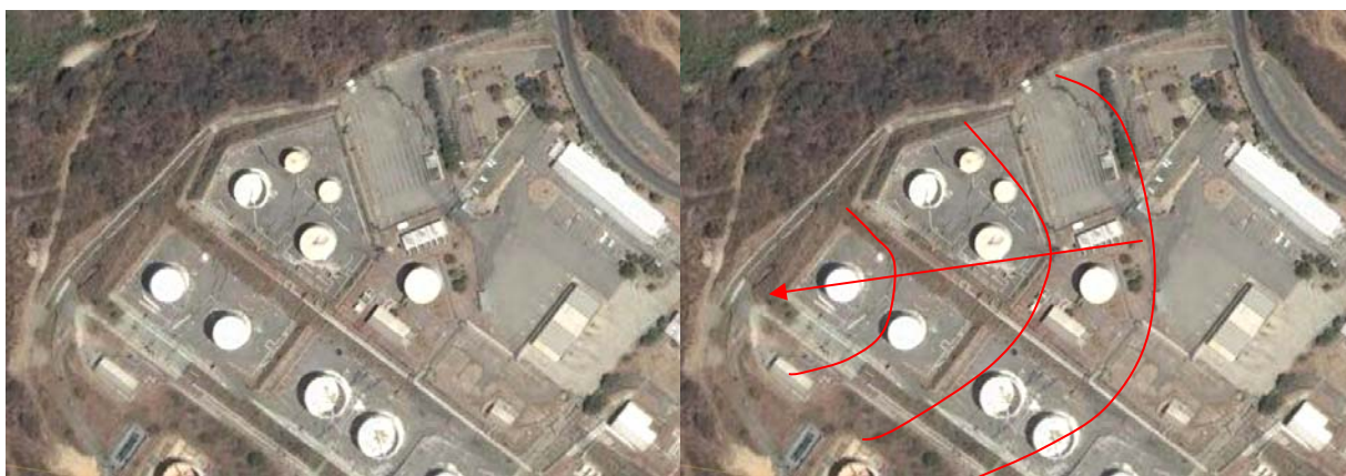
Figura 6.55.- Imagen satelital de la Planta PDVSA Cantinas (2003) obtenida del programa google earth. Se observan las fracturas en el asfalto que evidencian la dirección del deslizamiento
