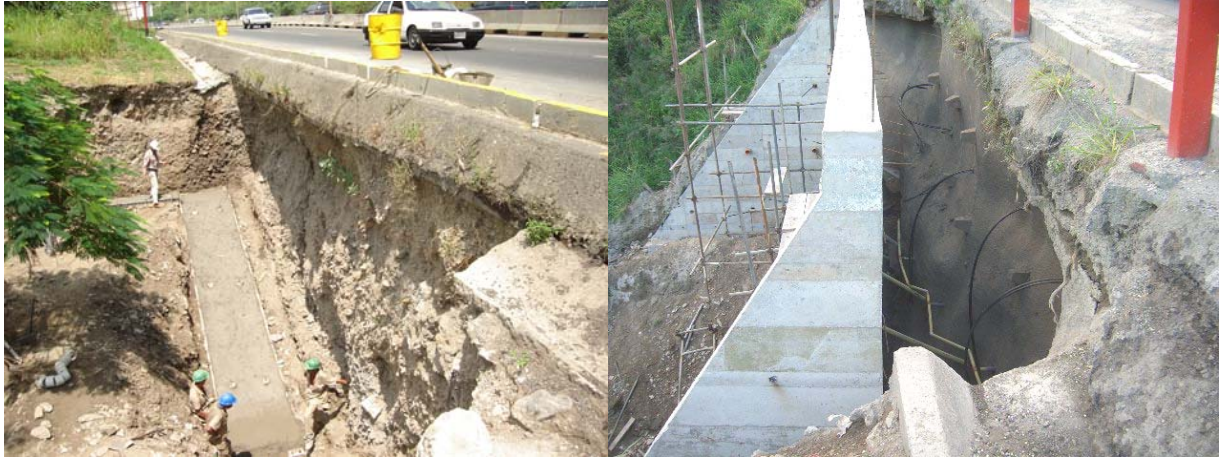
Figura 6.3.- Izquierda (agosto de 2005).- Construcción de un muro cantiliver para contener la base del terraplén de la vía en la progresiva 1+950 Derecha (enero de 2006).- Fue necesario construir una pantalla atirantada provisional para contener el material de relleno hasta que se terminara el muro
