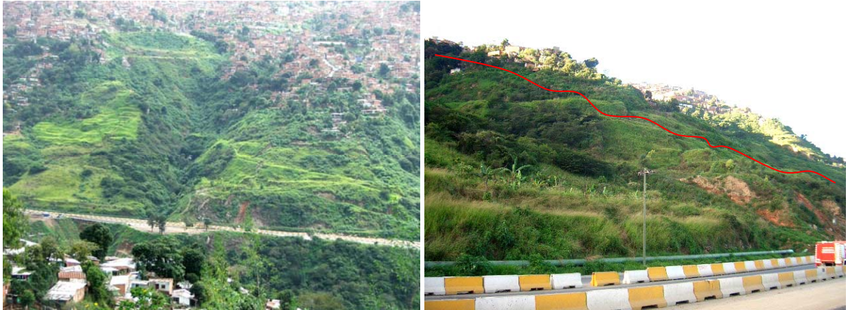
Figura 6.26.- Izquierda.- Se observa la topografía escalonada, así como el cambio de color de la vegetación que evidencia dos deslizamientos que ocurren a cotas mayores que la autopista, foto D. SALCEDO (2006) Derecha.- Vista de perfil del deslizamiento del Barrio 19 de Abril, hay evidencias de escalonamiento por deslizamiento del material.
