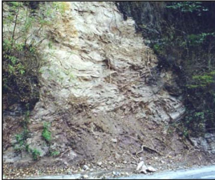
**Figura 27.** Caída de granos por descascaramiento y lavado superficial.
