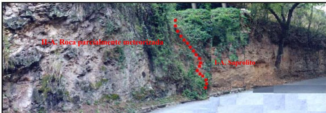
**Figura45.** Detalle de talud en M8-ESTC 8, indicando horizontes de meteorización y deformación de la masa rocosa.
