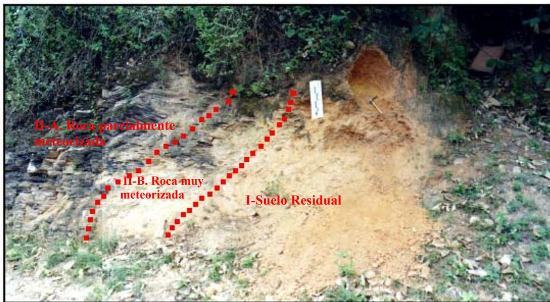
Figura 33. Detalle de talud en M2-ESTC 2, indicando horizontes de meteorización
