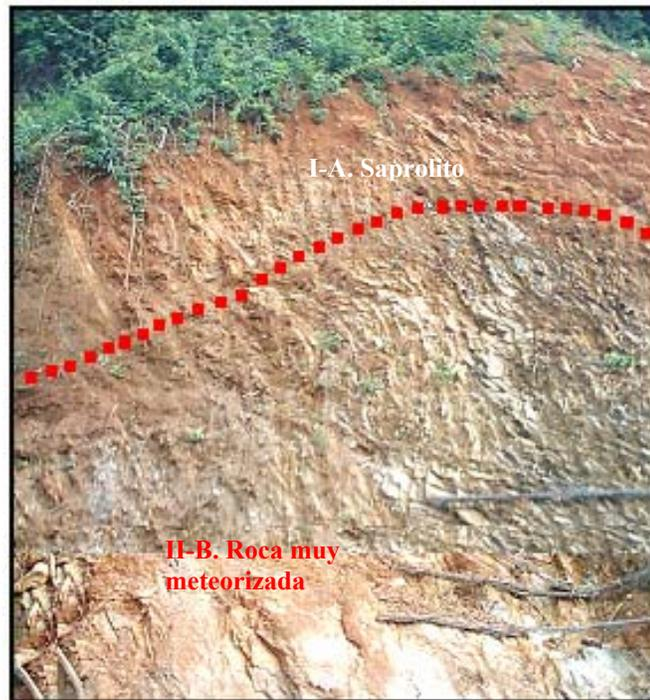
**Figura 62.** Detalle de talud en M6-ESTC 6, indicando horizontes de meteorización
