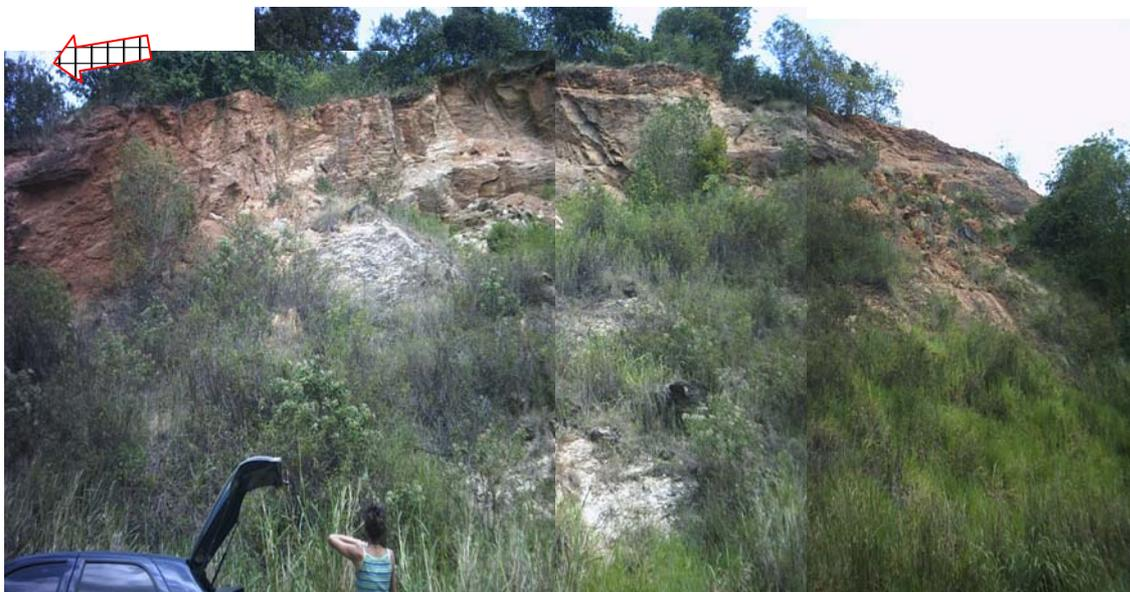
**Figura 49:** Deslizamiento rotacional simple, ubicado en la carretera hacia Urama (pto 135), se observa en gran tamaño del escarpe principal y la geometría circular alargada de la corona.
