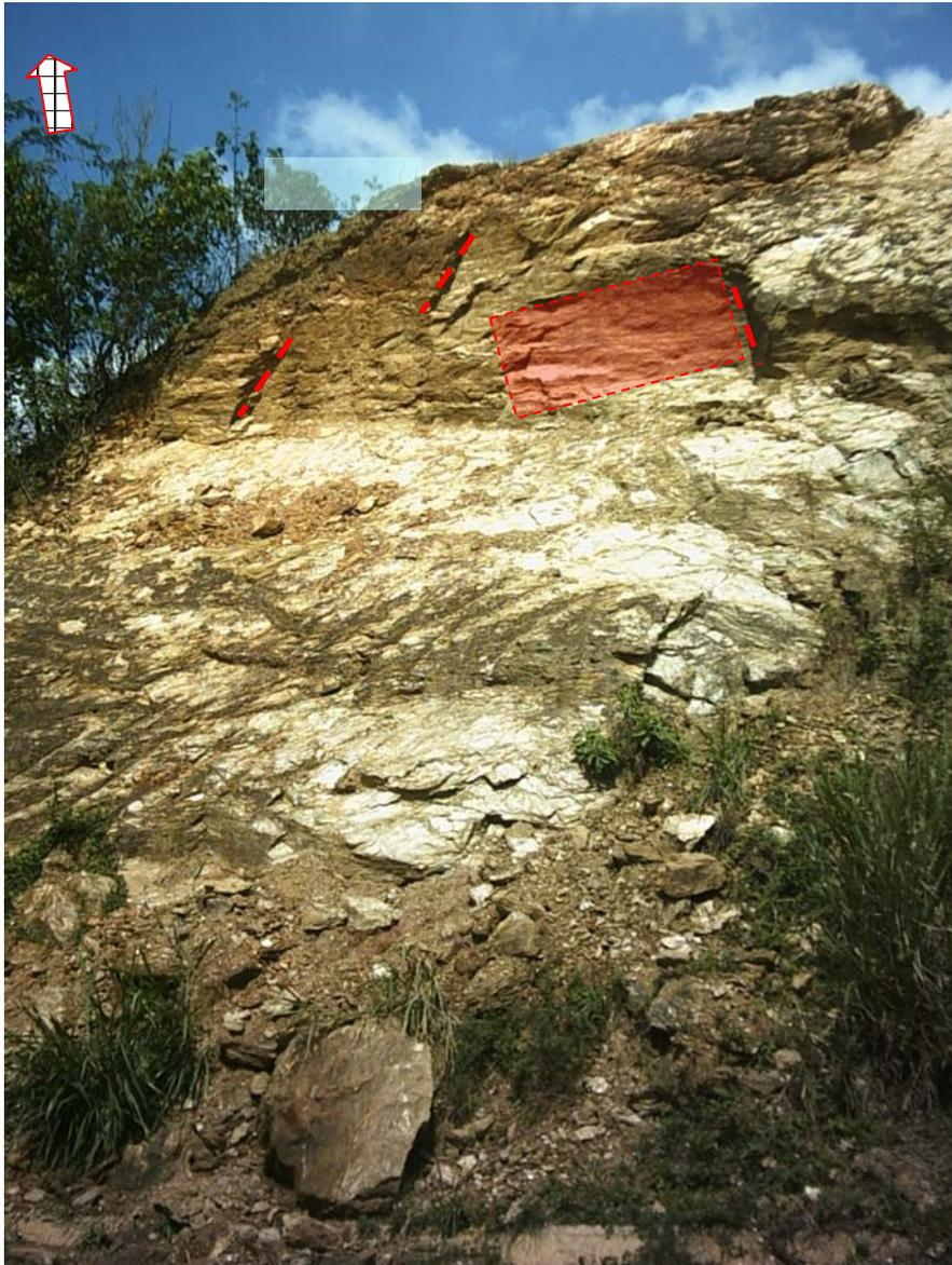
**Figura 50:** Deslizamiento Planar, ubicado en la carretera hacia Urama (pto 136), se observa claramente el plano del deslizamiento y como queda expuesta la roca sana muy moscovítica presente en la zona. En la parte superior del escarpe se observan al menos 2 familias de diaclasas, las cuales fracturan al bloque para que pueda ser desplazado. (rumbo de la foto N10°E).
