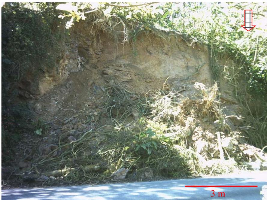
**Figura 39:** Flujos de detritos, (I) ubicado en la carretera hacia Palmichal (pto 150 ) se observa en forma de corte como es la geometría del material desplazado; (II) ubicado en la carretera Bejuma – Canoabo (ptos 117) resalta la cantidad de plantas mezclados con los cantos y matriz.
