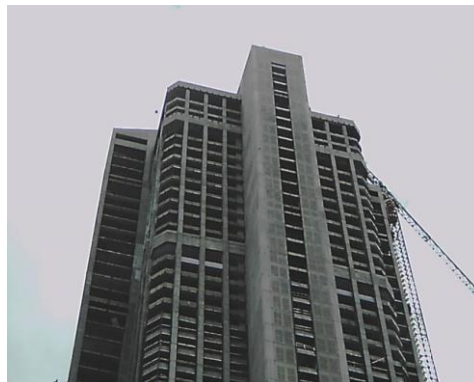
Vista de los trabajos de refacción de la Torre.
