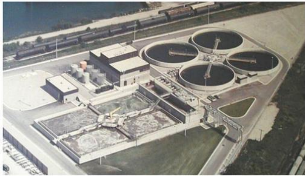
Fig. 5 Planta de tratamiento de aguas residuales industriales Chemical Park Sarnia, Ontario - Canadá. Fuente: Chemical Park Sarnia, [on-line] URL: www.chemicalparksarnia.com . Última revisión: 01/11/2009 (23) .
