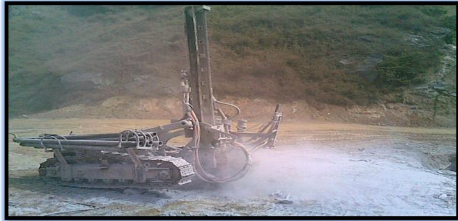
Figura 3.5: Equipo de Perforación Stenuich con Martillo de Fondo.
