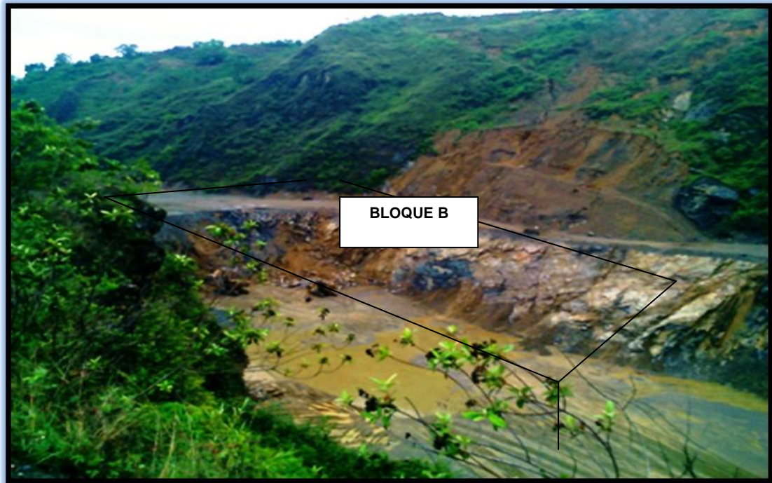
Figura 2.4: Bloque B. Oeste de la Cantera La Ceiba, C.A. Fuente: Elaboración Propia.
