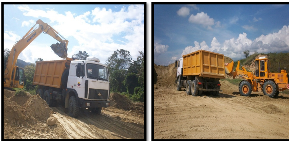
Figura 13: Corte y Carga
