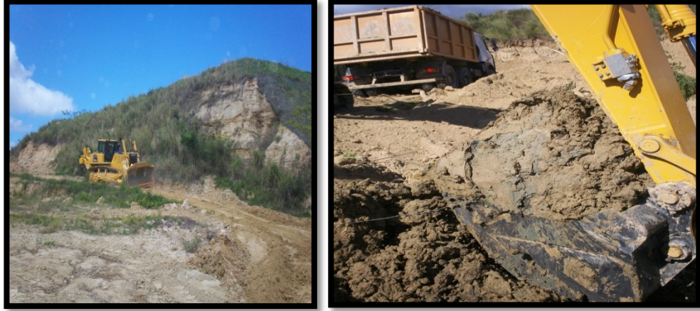
Figura N° 12: Se observa el método de remoción y extracción de materiales arcillosos con el tractor de oruga y retroexcavadora
