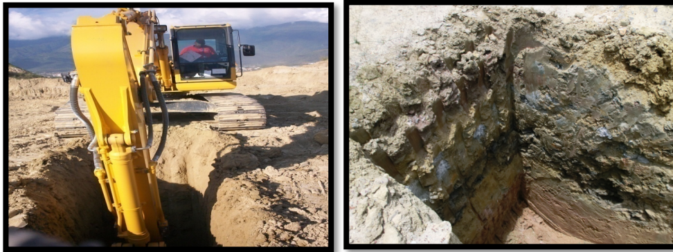
Apertura de la calicata
