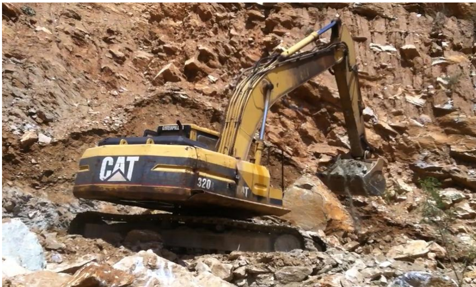
Imagen N°4 Excavadora Cat-320. Fuente: Propia, 2016
