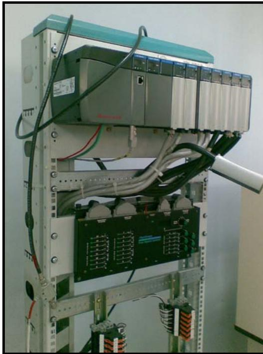
**Figura N° 52. Gabinete de conexión donde se encuentra ubicado el C-200** (Elaboración Propia).
