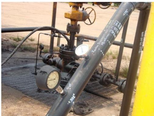
**Figura N° 10** Manómetro y Termómetro ubicado en la salida del pozo.
