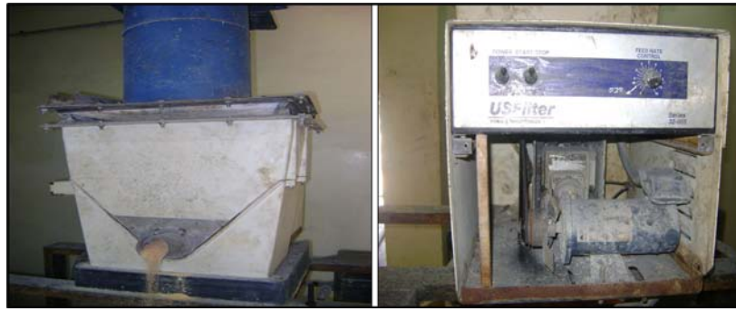
Figura III.35 Dosificador de sulfato.
