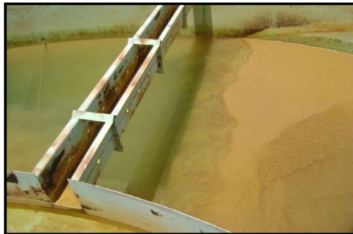
Figura III.19 Lavado de Acelerator tipo “NS”. Planta Potabilizadora Santa Clara, Clarines. Edo Anzoátegui.
