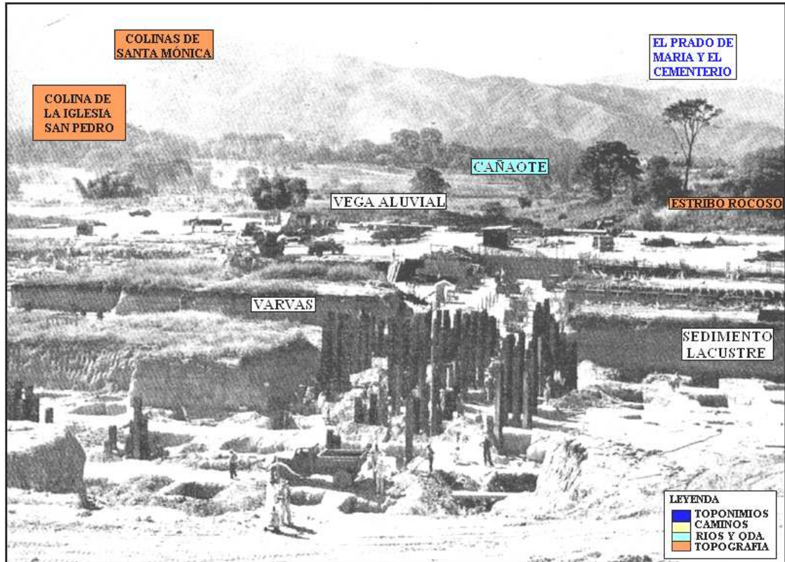
Figura 4.13. Fundaciones sobre pilotes, Hospital Clínico, Ciudad Universitaria. Revista del Colegio de Ingenieros de Venezuela, Caracas, Revista N° 190 enero de 1952. Fotografía sin año.
