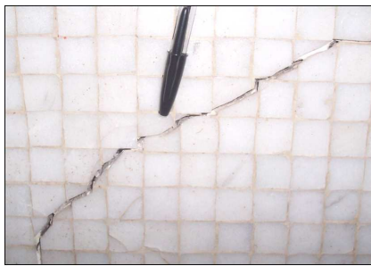
Figura 5.17. Entrada este al edificio de la Escuela de Ingeniería Química, en la Planta Baja del edificio se observan grietas con desplazamiento ver detalle Fotografía: Ramos, 2010.
