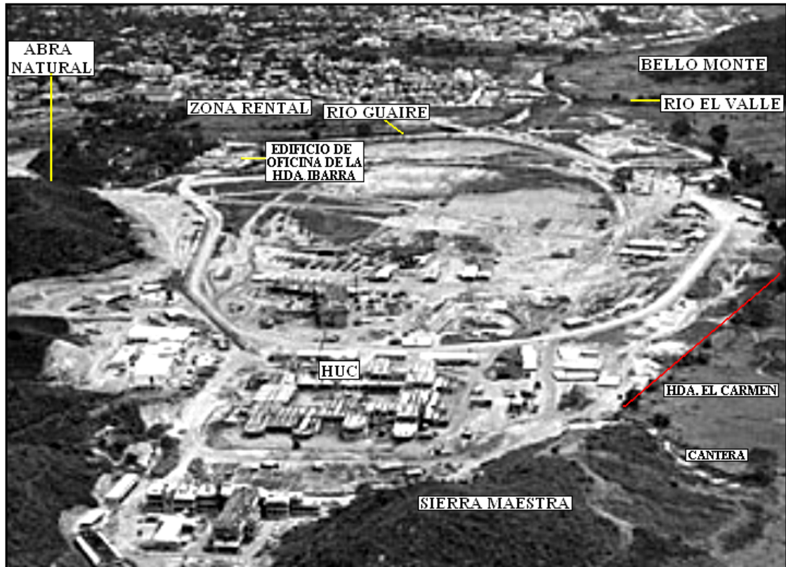
Figura 4.14. Fotografía con vista al Este de la Ciudad Universitaria de Caracas en construcción. Cortesía del Profesor Miguel Castillo. Fotografía sin año.
