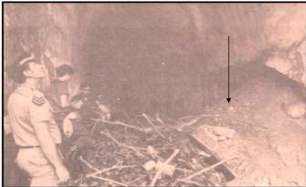
Figura 5.11. Imagen del colapso del túnel del tranvía Caracas-El Valle por efecto chimenea. Tomaron de El Diario de Caracas, Edición Especial 1981-1982, 3 de mayo de 1982, página 40.
