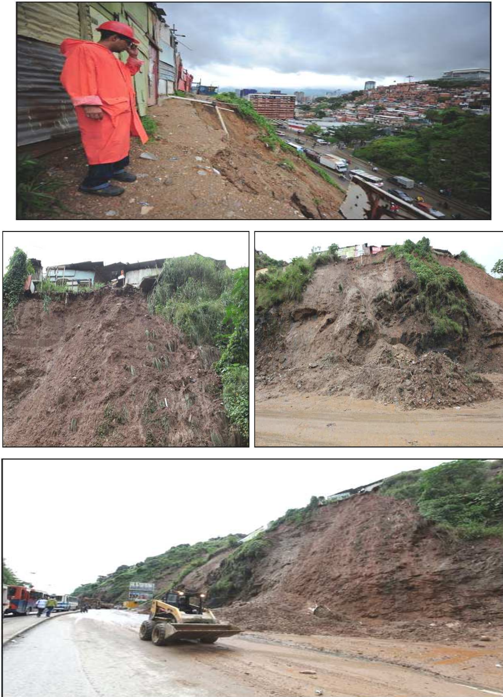
Figura 5.21. Derrumbe en La Roca Tarpeya producto de torrenciales lluvias ocurrido el 01 de diciembre de 2010. Tomado de http://www.notiactual.com/roca-tarpeya-y-petare-al-filo-del-desastre-fotos/ .
