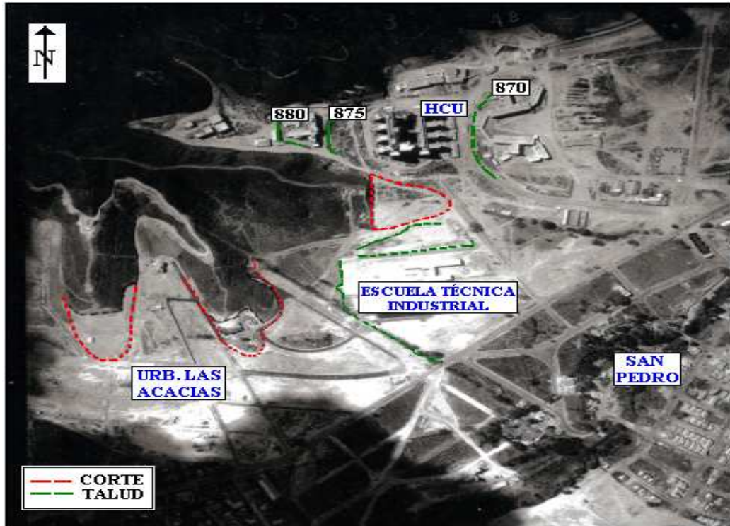
Figura 3.25 Corte del estribo de la actual Sierra Maestra y la Urb. Las Acacias. Fotografía aérea # 034, Misión B8, año 1949. Las líneas punteadas de color rojo representa el corte del estribo norte para la construcción del Decanato de Medicina y otras edificaciones en la UCV y la urbanización las Acacias. Las líneas de color verde indican terrazas o desniveles en el terreno.
