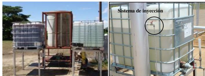
Figura 58. Tanques de almacenamiento y sistemas de inyección del producto
