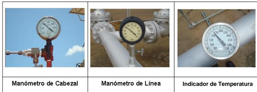
Figura 59. Equipos de medición en línea de presión y temperatura
