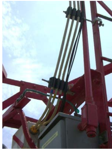
Figura 39. Recorrido de energía y fibra óptica sujeto con grapas
