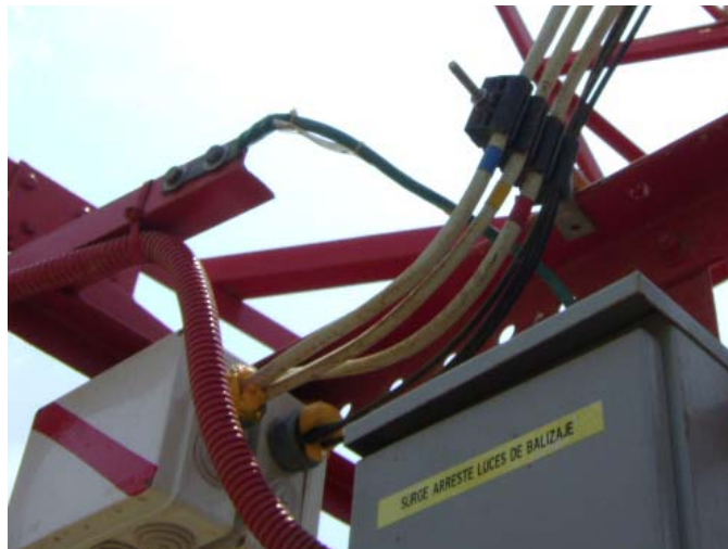
Figura 38. Caja de paso instalada para energía
