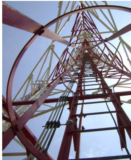
Figura 40. Recorrido vertical de energía y fibra óptica
