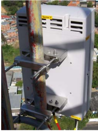
Figura 43. RRU instalada
