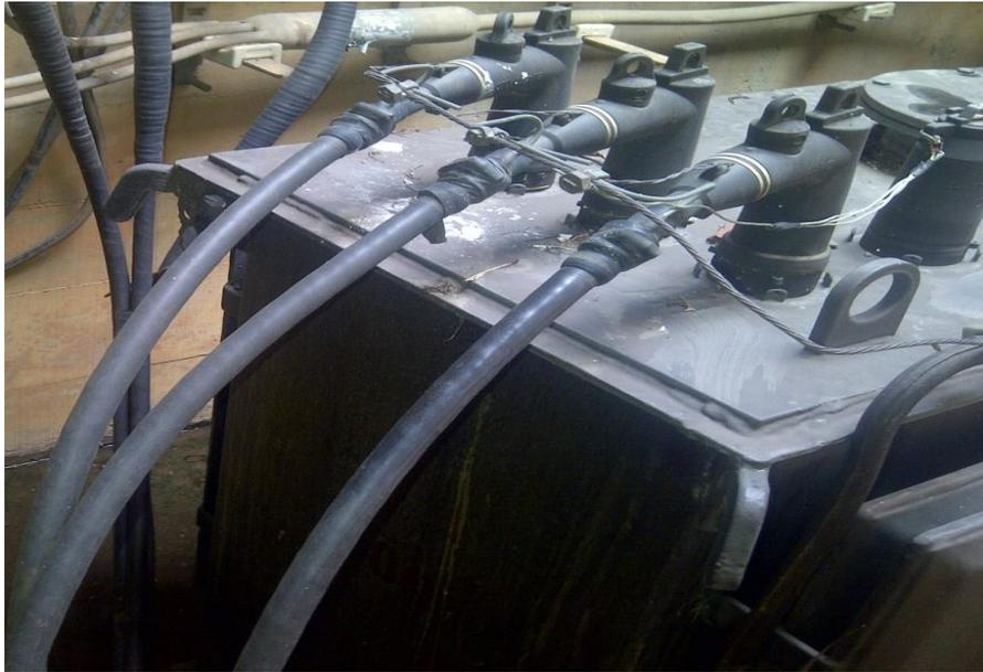
Figura 39. Lado de alta tensión en el transformador de Jardín Botánico de Caracas.
