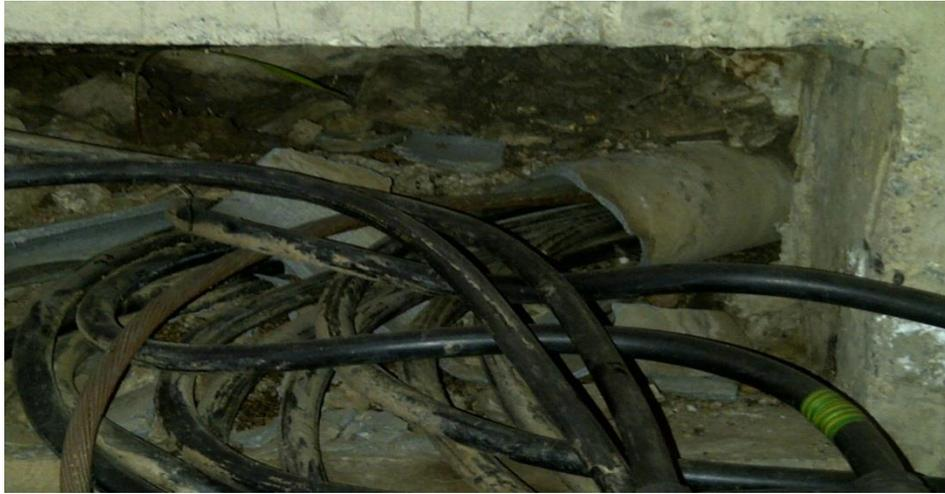
Figura 36. Bancada de baja, en el sótano de aulas.
