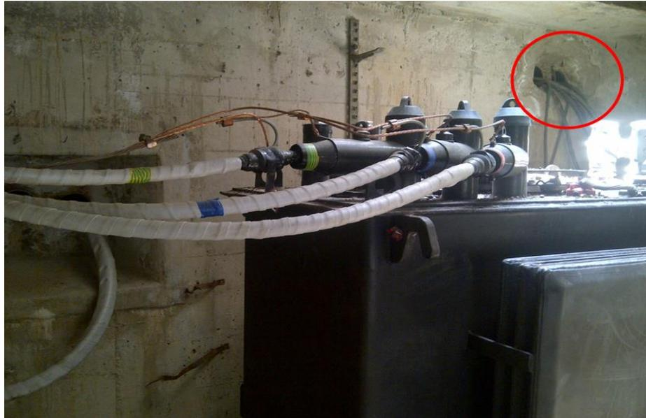
Figura 35. Sótano del edificio de Aulas, sin cortafuegos en la salida de baja tensión.
