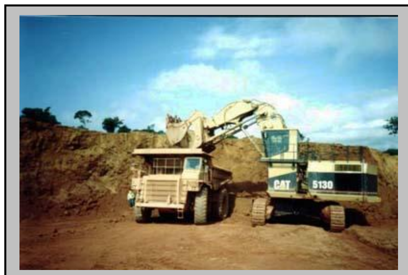
Figura 4.4. Pala hidráulica CAT 5130.
