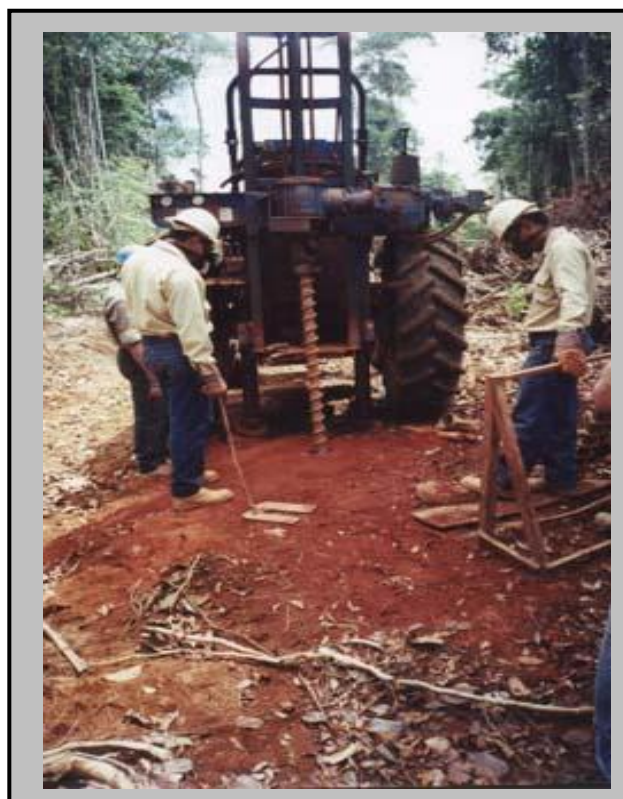
Figura 3.1. Método de perforación helicoidal o Tornillo sin fin.
