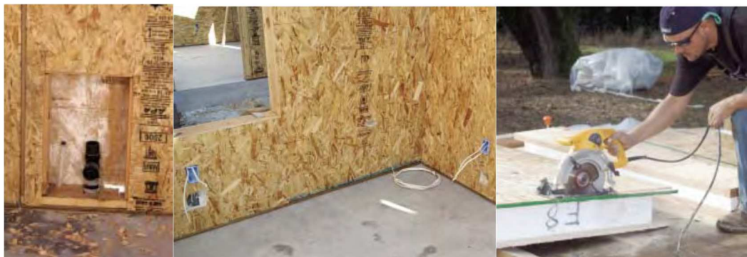
Fig. 6: Instalaciones en SIPS. Fuente: Building with SIPS, Morley (2000)
