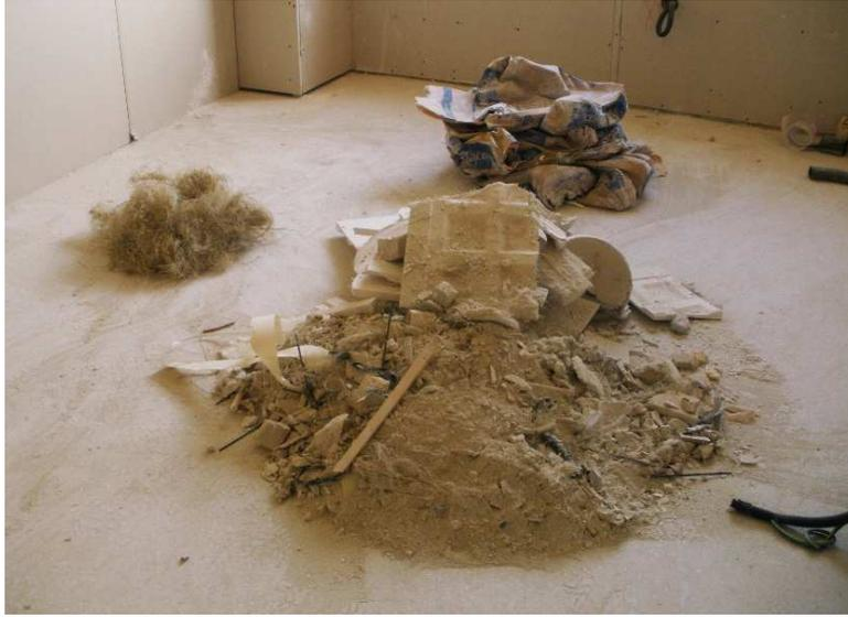
Figura 1. Residuos de unidad: Techo de Escayola, separados y amontonados en el lugar del tajo para su medición.
