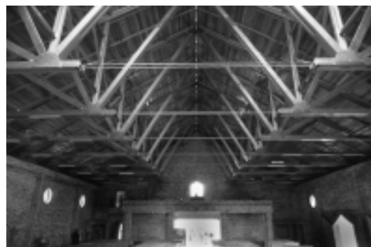
Fuente: Estructura de techo. Iglesia diseñada por Urbano Ripoll. Bogotá. Colombia (foto: A. Loreto).
