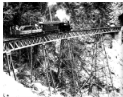
Fuente: Túnel y puente del gran ferrocarril en Venezuela hacia el año 1891 (Maldonado B.C. Ingenieros e ingeniería en Venezuela siglos XV al XX 1997).
