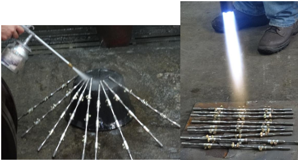
Figura 18 Limpieza con thinner y calentamiento previo al recubrimiento
