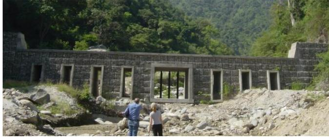
**Ilustración 8. Presa abierta con ventanas en la quebrada Camurí Chico, estado Vargas**
