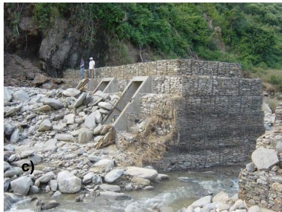
**Ilustración 60. Vista desde aguas arriba mostrando la similitud de los procesos de sedimentación en presas abiertas: a) ensayo en canal didáctico; b) y c) río Camurí Chico en el estado Vargas después de la creciente de febrero del 2005.**
