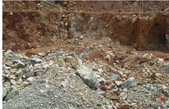
Figura 8. Vista de las calicatas en campo.
