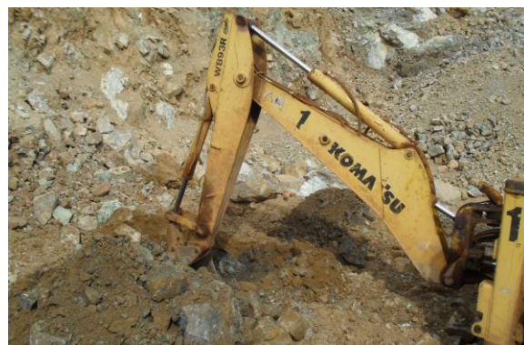
Figura 9. Desarrollo de las calicatas y distribución de los pilas.
