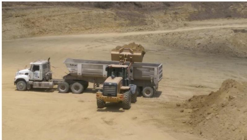
Figura N°13: Cargador frontal en proceso de carga del camión
