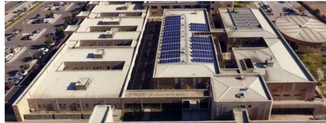
Hospital Provincial del Huasco en Chile con un sistema de energía solar fotovoltaica conectado a la red. Fuente: EPIA, 2011
