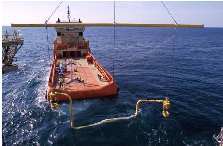
Figura 2.11 Operaciones para instalar un jumper . Tomado Pemex-ABB, 2009
