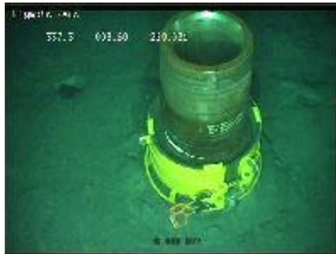
Figura 2.8 Cabezal submarino instalado en el lecho marino. Tomado Pemex-ABB, 2009.
