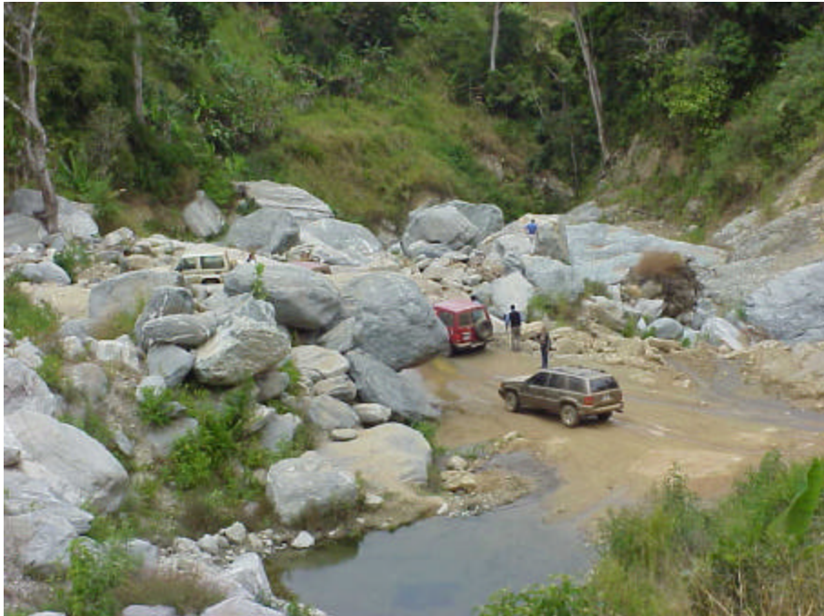
Figura 27 Detalle del cruce de la carretera en la confluencia de cauces en la Qda. Los Perros, vista desde aguas arriba (Fuente: IMF)
