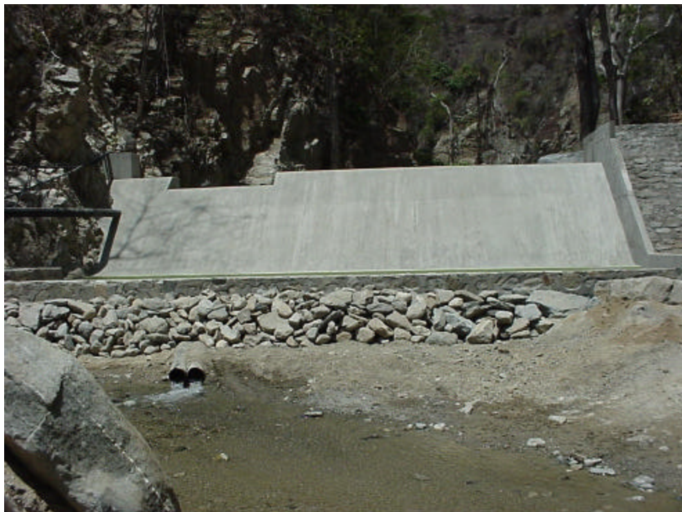
Figura 7 Dique toma reconstruido aguas arriba de la población de Macuto. Noviembre 2001.
