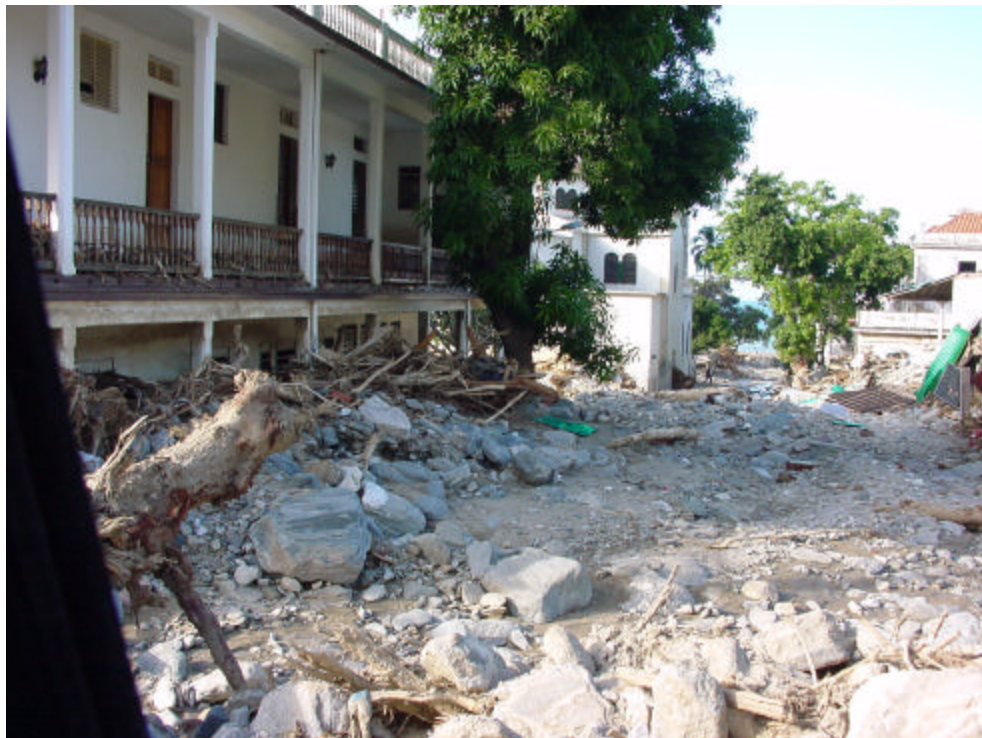
Figura 21 Población de Macuto. Parte baja del cono de deyección, se observa la deposición de sedimentos, piedras, vegetación y escombros. Vista desde la Av. Intercomunal hacia aguas abajo. Diciembre 1999.
