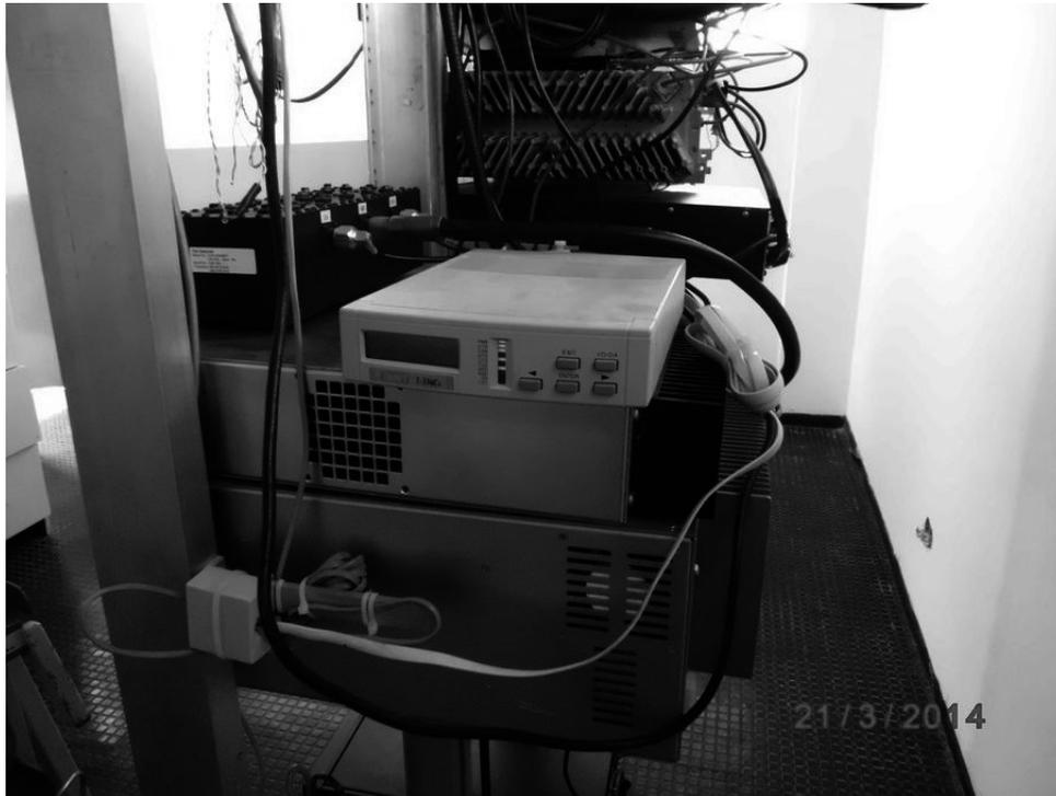
**Figura 4.5:** *Detalle del módem de la MTU, estación El Junquito*
