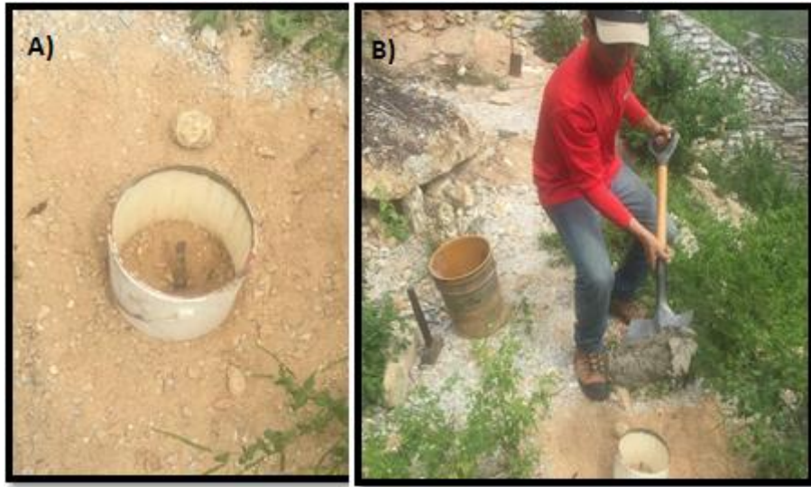
Figura 22. A) Ubicación de encofrado. B) Vertido de concreto
