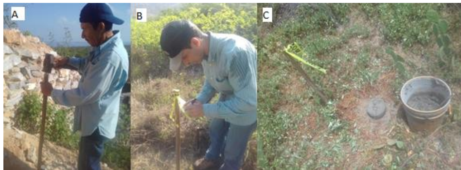
Figura 6. A) Proceso de ubicación de los puntos, B) Etapa de nombrar los puntos, C) Creación de los monumentos de concreto en los puntos ubicados.
