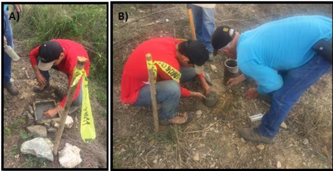
Figura 23. A) Identificación monumento. B) Separación del encofrado.
