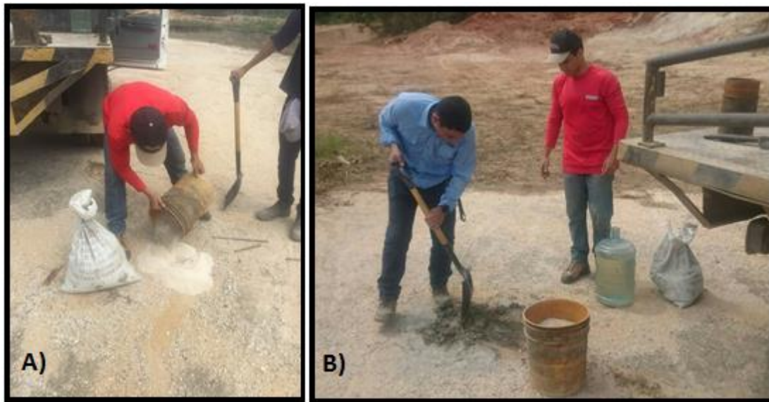
Figura 21. A) Mezcla de áridos y cemento. B) Elaboración de concreto
