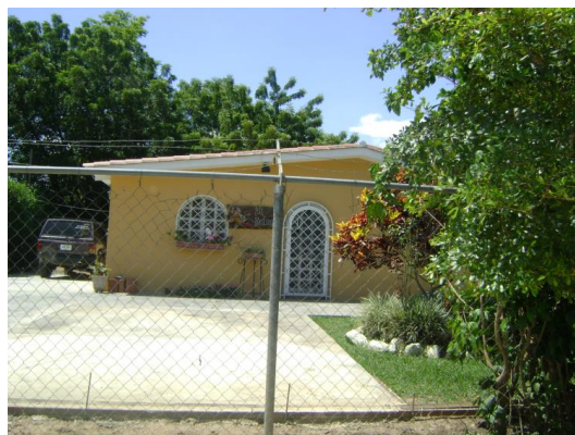
Foto N° 26: Casa con relleno de terreno
